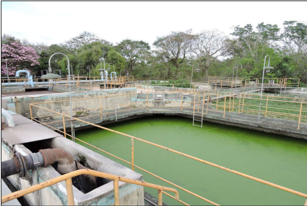
ETE - TANQUE DE AERAÇÃO - CONCRETO
