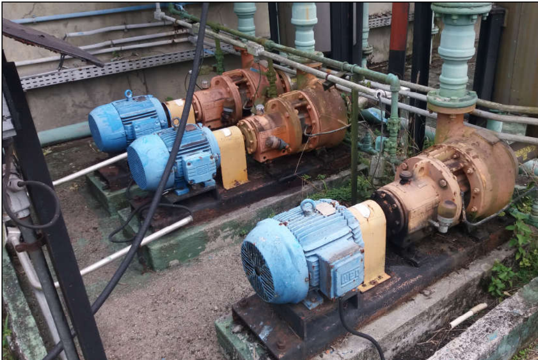
ITENS 1,003; 1,004; 1,005 – ETE - BOMBA CENTRIFUGA, FAB. OMEL, MOD. UND II 4X3X10 POL, MAT. AÇO INOX 316, VAZÃO 60 M3/H, ALTURA MAN. 15,25 M, ACIONAM. MOTOR ELÉTRICO POT. 10 CV E SELO MECÂNICO
