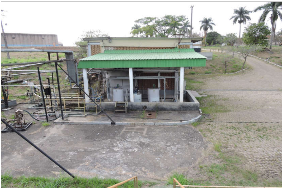
ETE - VISTA GERAL - TRATAMENTO FÍSICO-QUÍMICO
