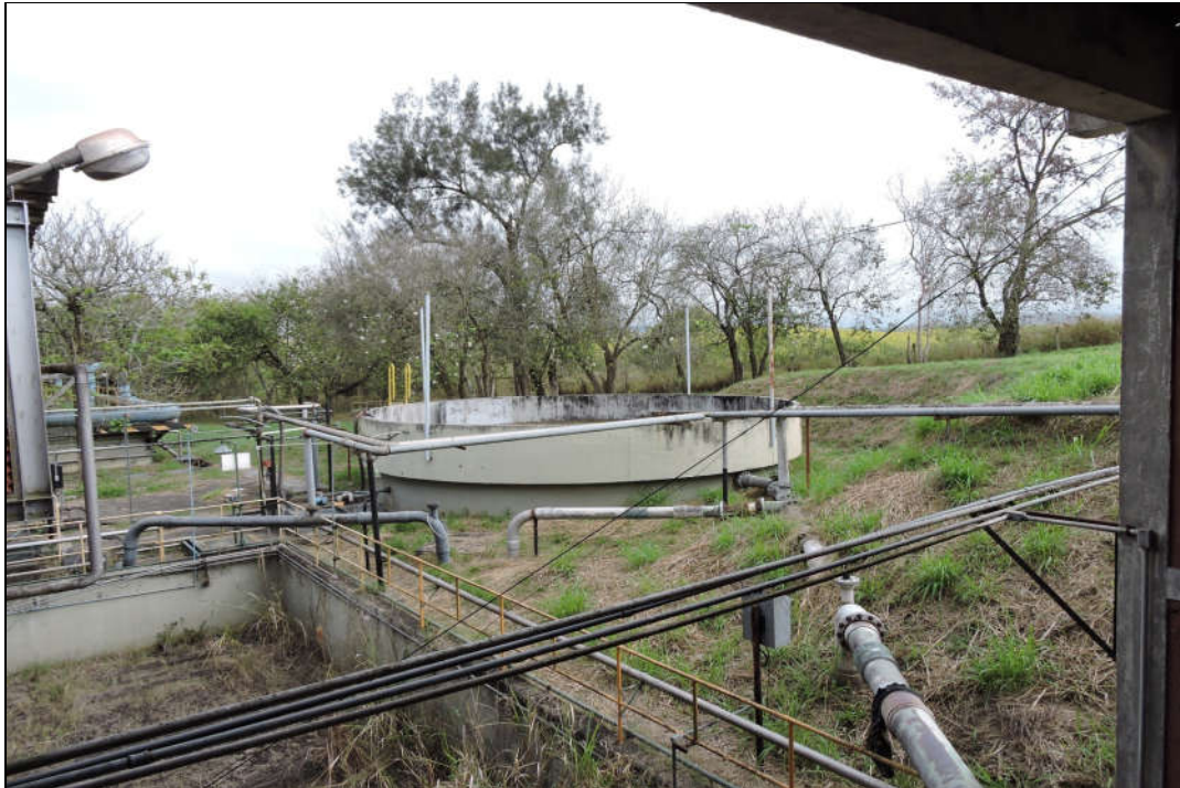
ETE - TANQUE DE EMERGÊNCIA - CONCRETO
