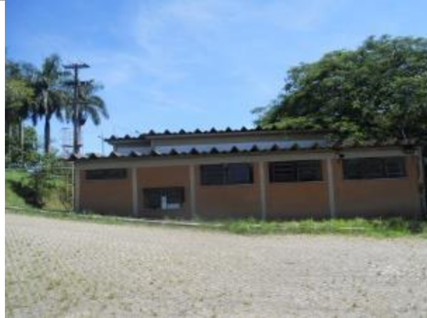
Vista da fachada
