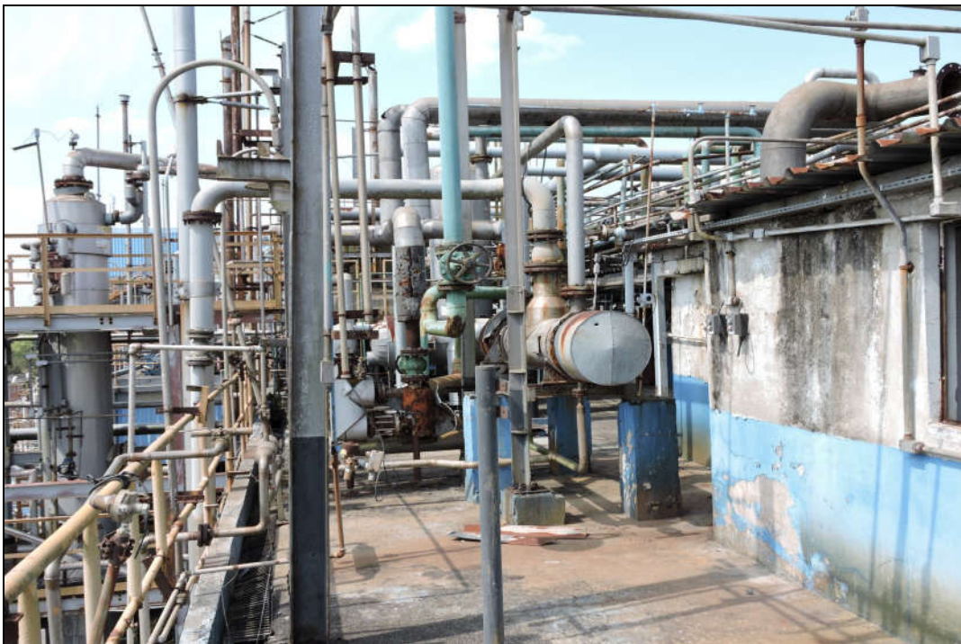
SÍNTESE - TIN SHOP - TERCEIRO PAVIMENTO - VISTA GERAL
