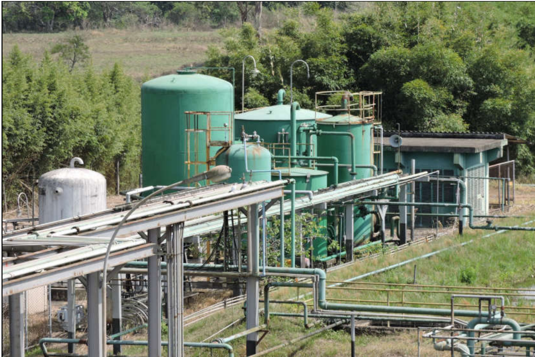
UTILDADES PLANTA NORTE ETA - VISTA GERAL
