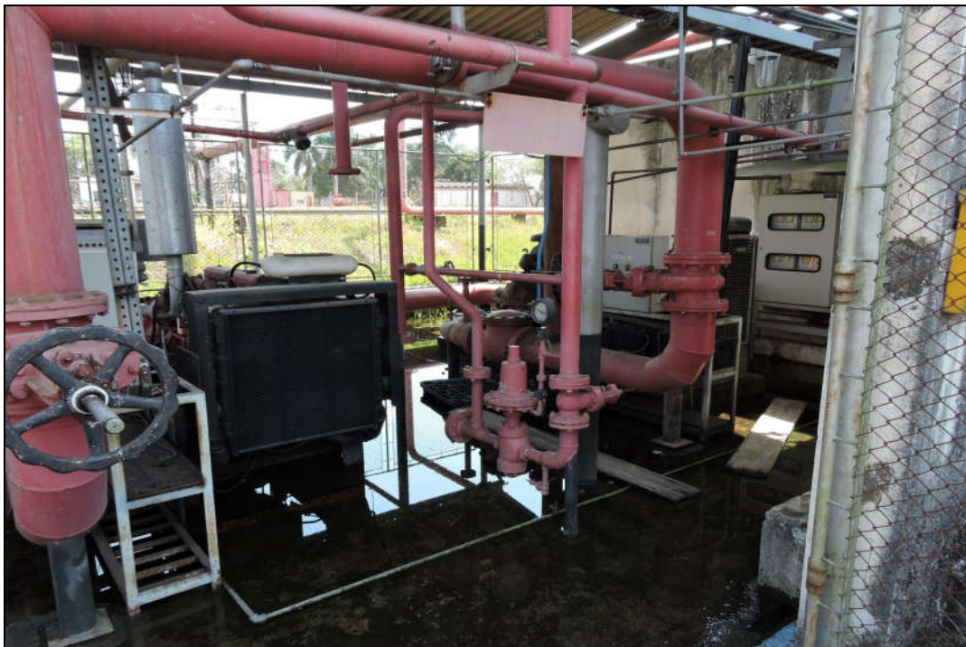
UTILDADES PLANTA NORTE - MOTO-BOMBAS DE INCENDIO
