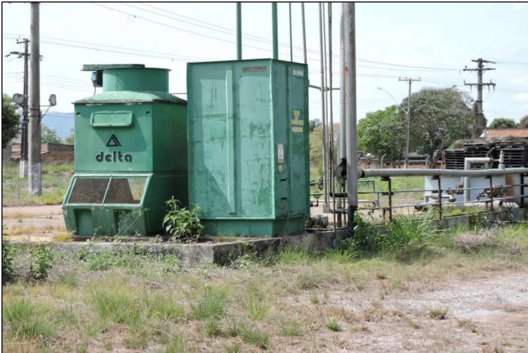
FORMULAÇÃO NORTE – HERBICIDA - TORRE DE RESFRIAMENTO
