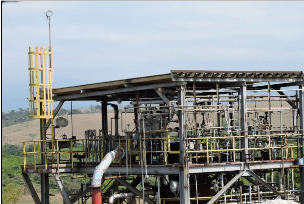
INCINERADOR - DETALHE DO PISO SUPERIOR
