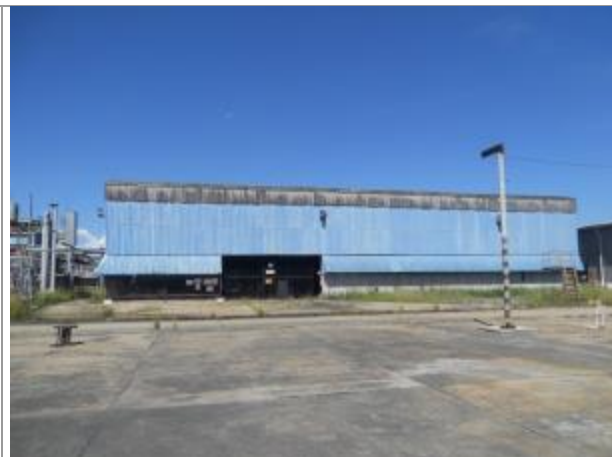
Vista dos fundos
