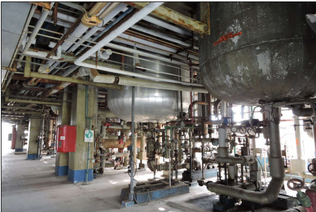
SÍNTESE - JOB SHOP - PRIMEIRO PAVIMENTO - VISTA INFERIOR TANQUES
