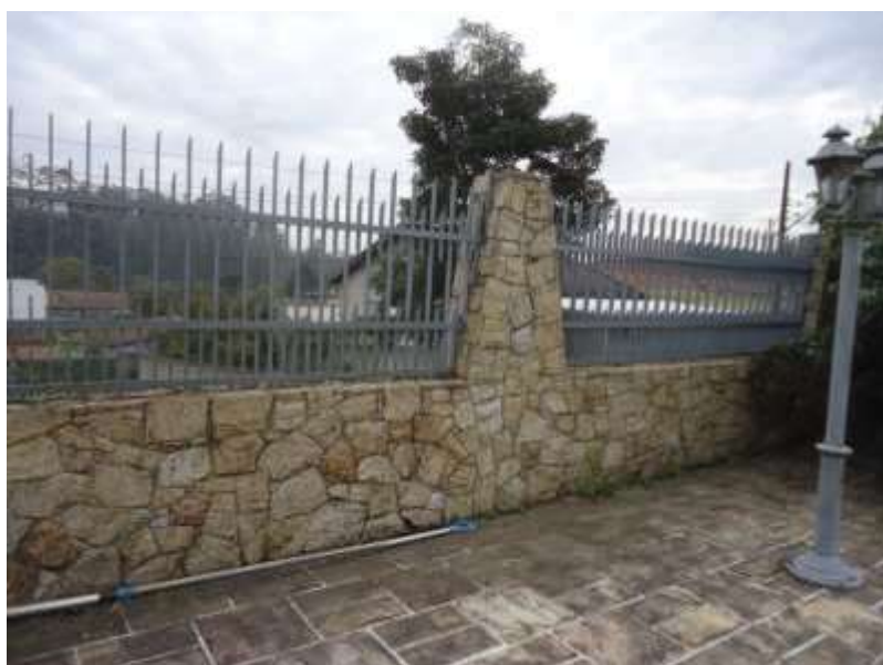
Muros (arrimo) altos para a Rua Jandaia
