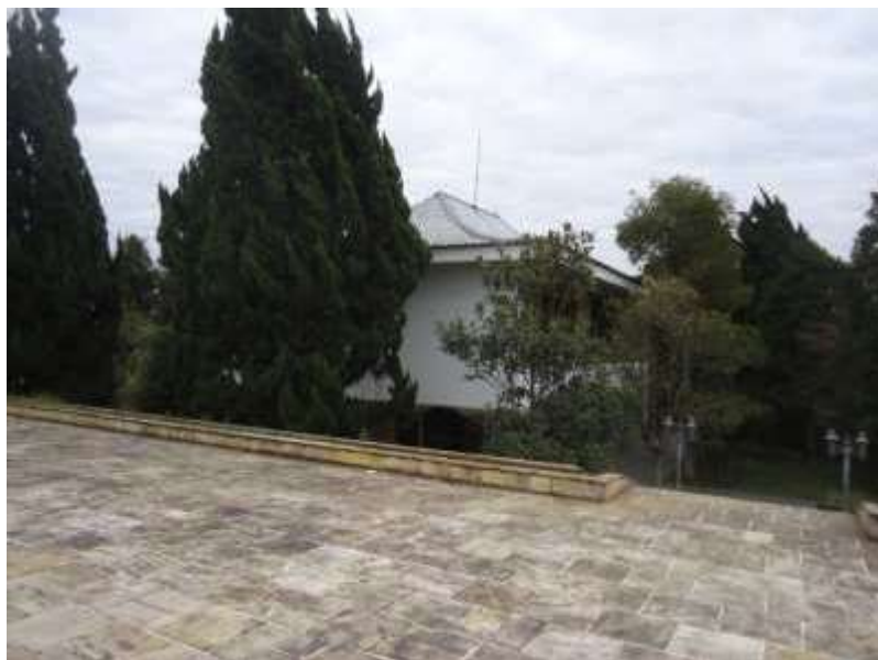
Observador voltado à escada de acesso das imagens anterior, já na área de piscina
