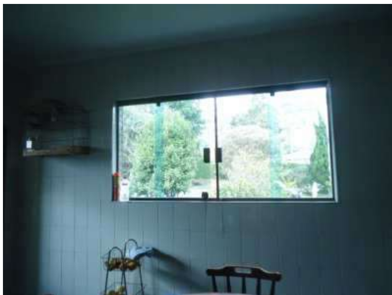
Cozinha do piso superior – a cozinha do piso inferior estava em obras durante a vistoria
