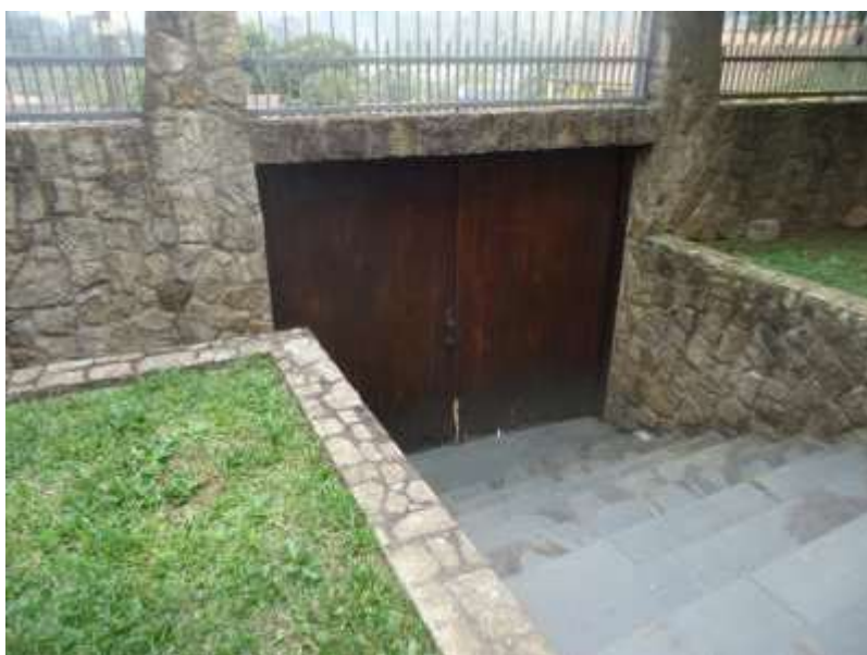
Interno da entrada social da R. Maquiru, completando o entorno da casa
