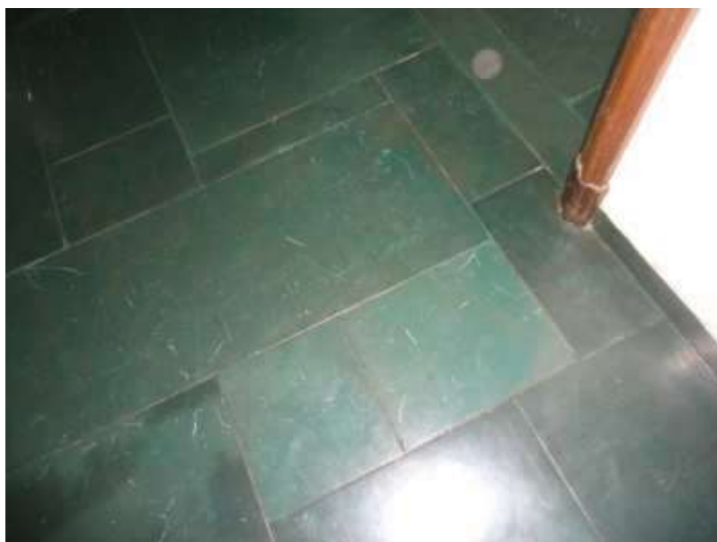
Ardósia que reveste todos estes ambientes inferior e segue até o corredor superior
