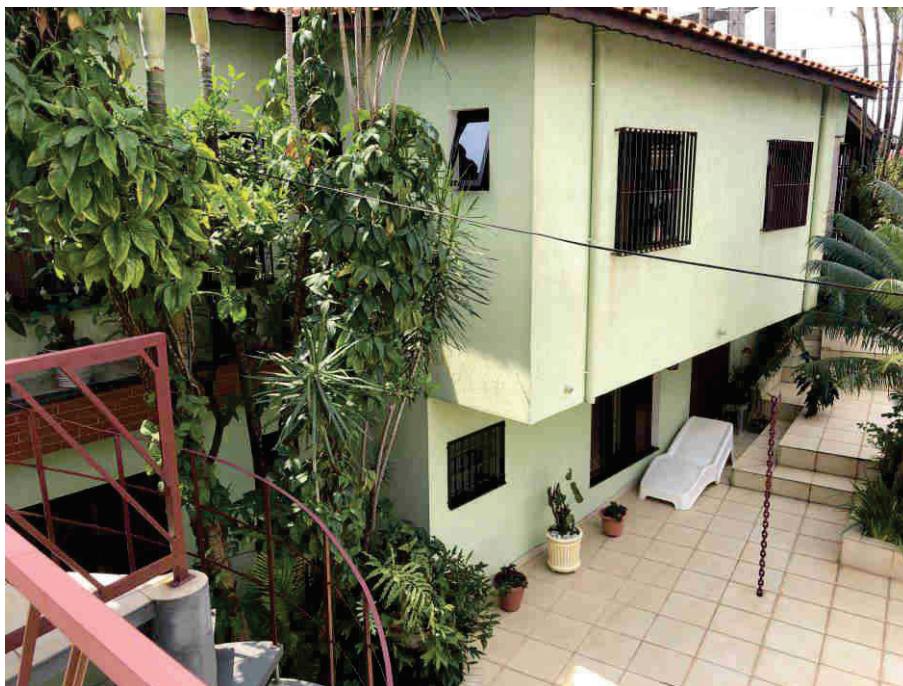
Imagem 51 - Porção lateral esquerda da casa vista do terraço.
