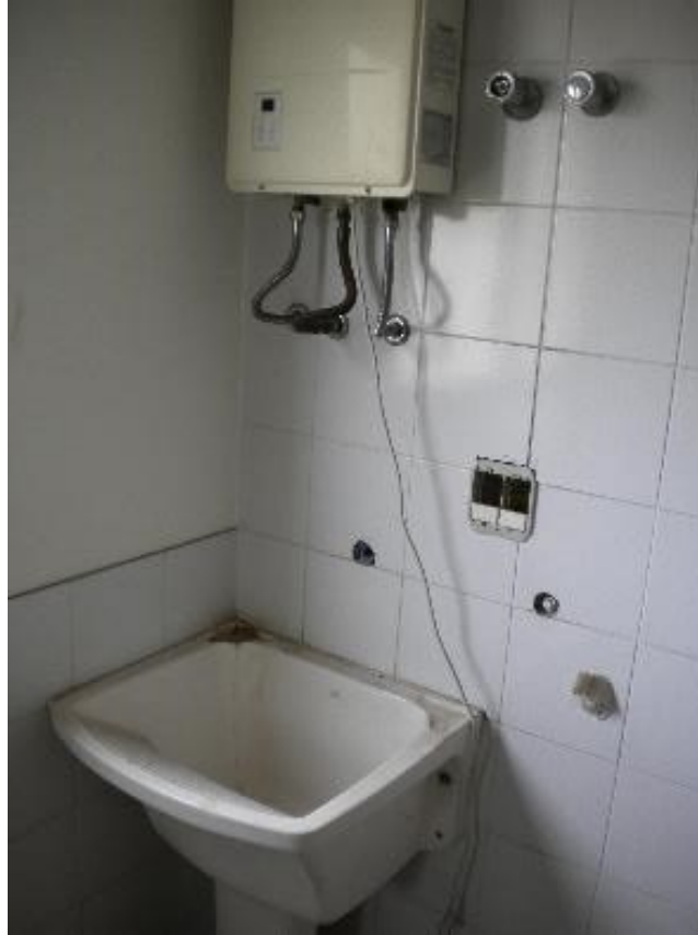
Foto nº 11 – Área de serviço e aquecedor a gás.
