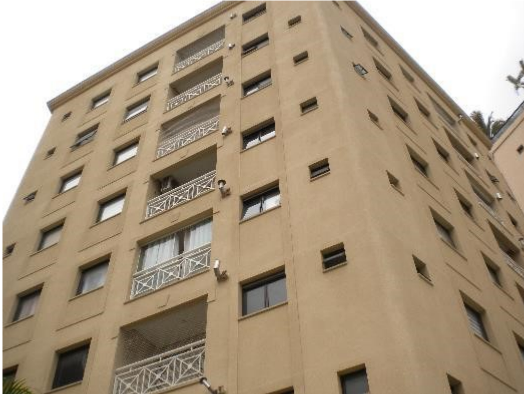
Foto nº 05- Fachada fundos do imóvel.
