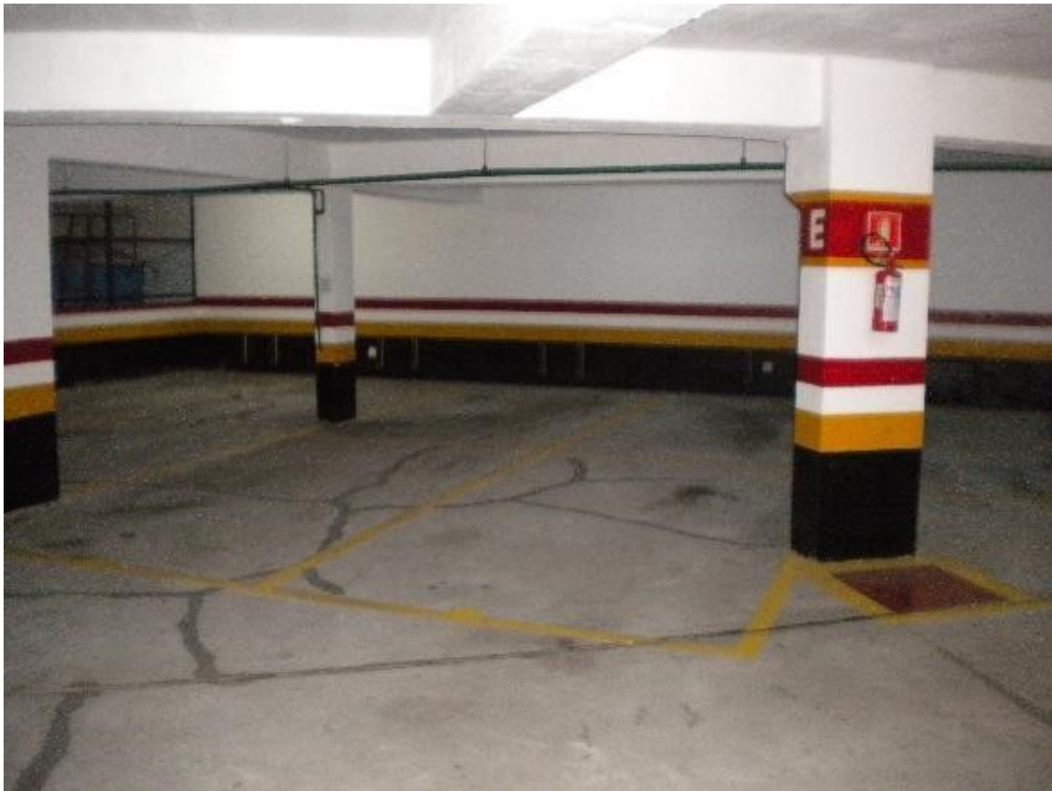
Foto nº 20 – Vagas no 2º subsolo.
