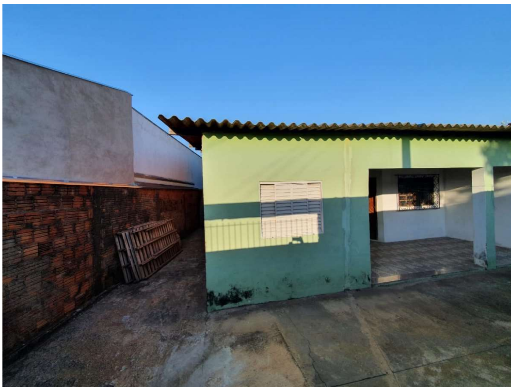
Vista do interior do imóvel objeto
