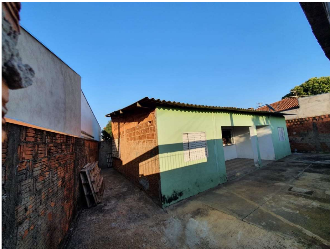
Vista do interior do imóvel objeto
