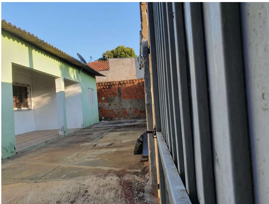
Vista do interior do imóvel objeto
