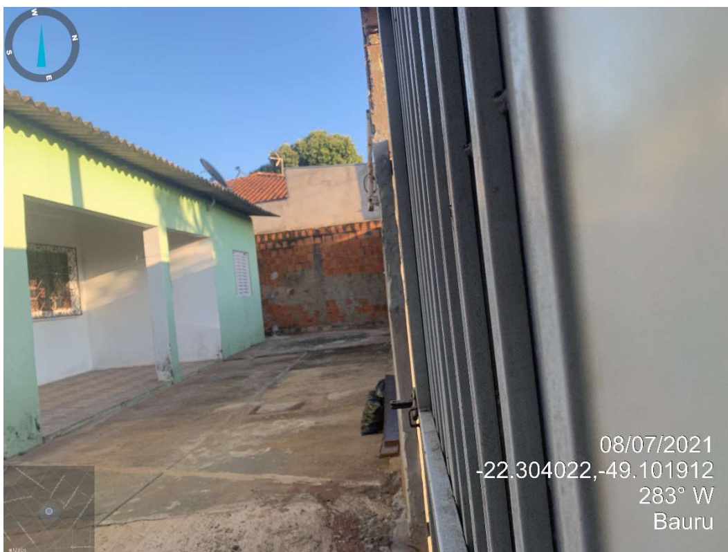
Vista do interior do imóvel objeto
