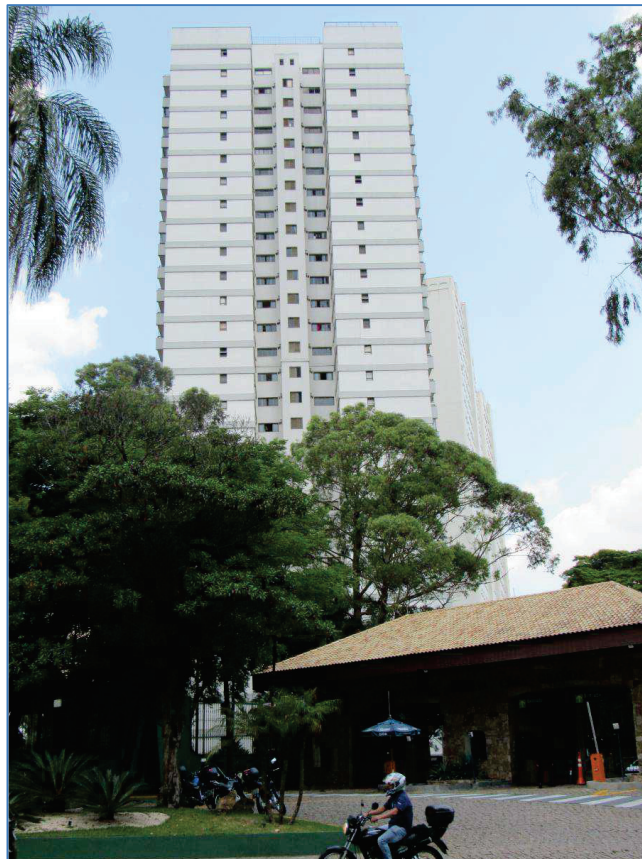
FACHADA DO CONDOMÍNIO RESERVA CASA GRANDE.
