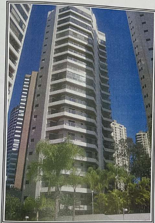
Foto n° 01: Vista geral do Edifício Orquídea
