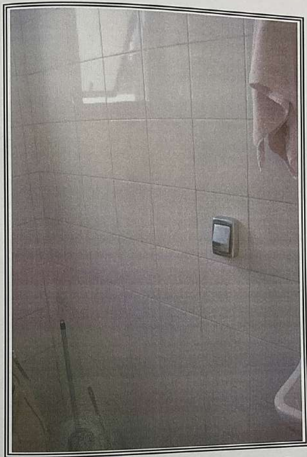
Foto n° 27: Vista do banheiro do quarto de empregada
