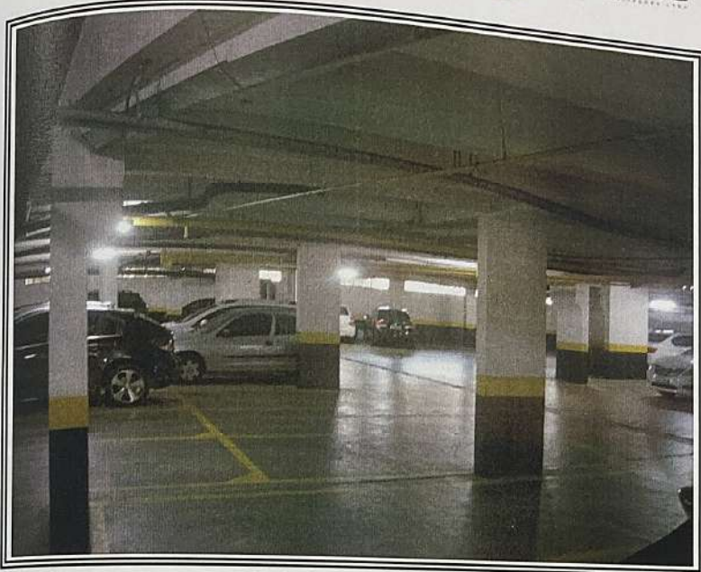
Foto nº 28: Vista geral da garagem no subsolo do Edifício Orquidea
