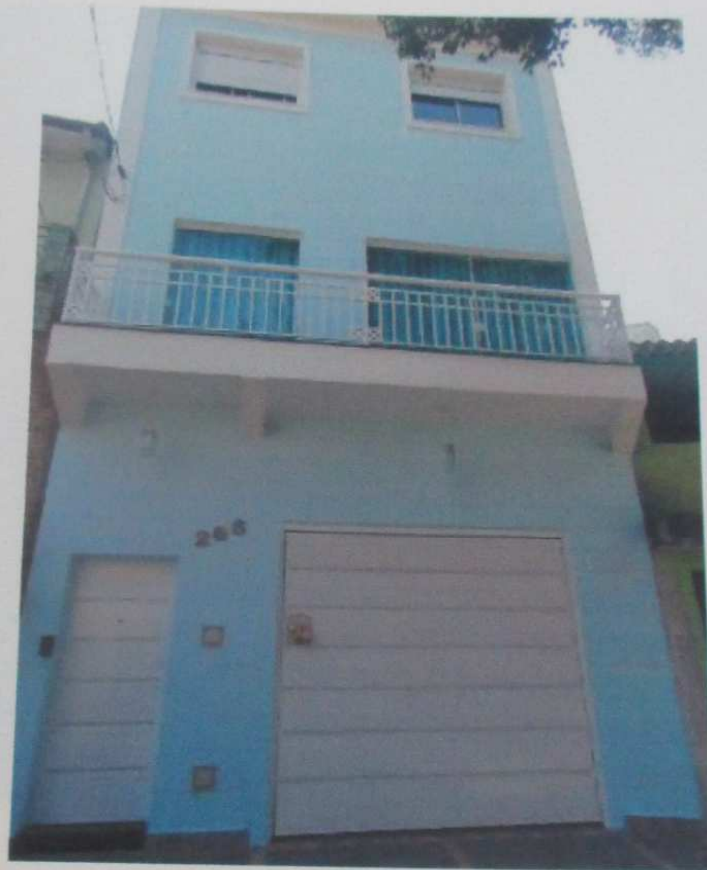
FACHADA DO IMÓVEL AVALIANDO.
