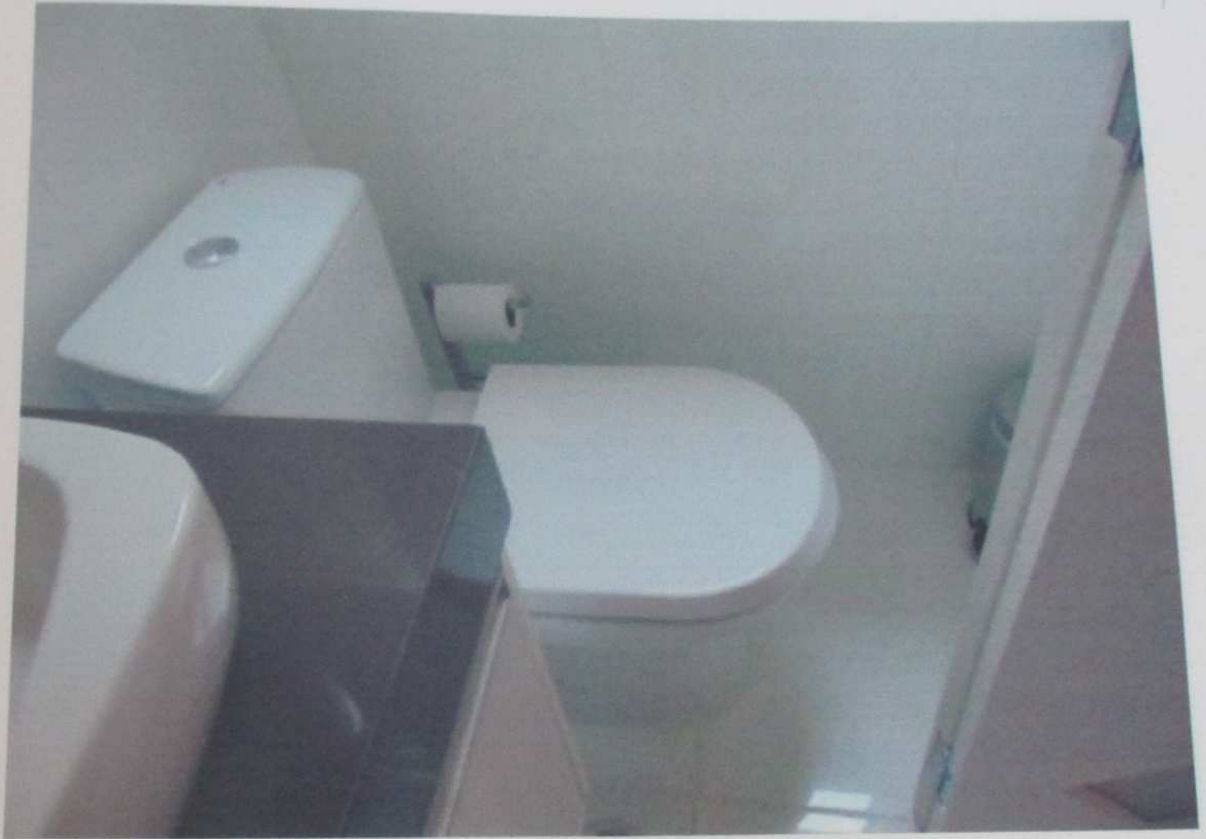
VISTA DO BANHEIRO DO QUARTO DO BEBÊ.
