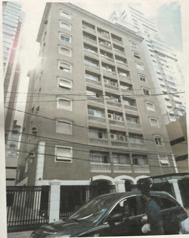
FOTO 02: - Vista da fachada do prédio.
