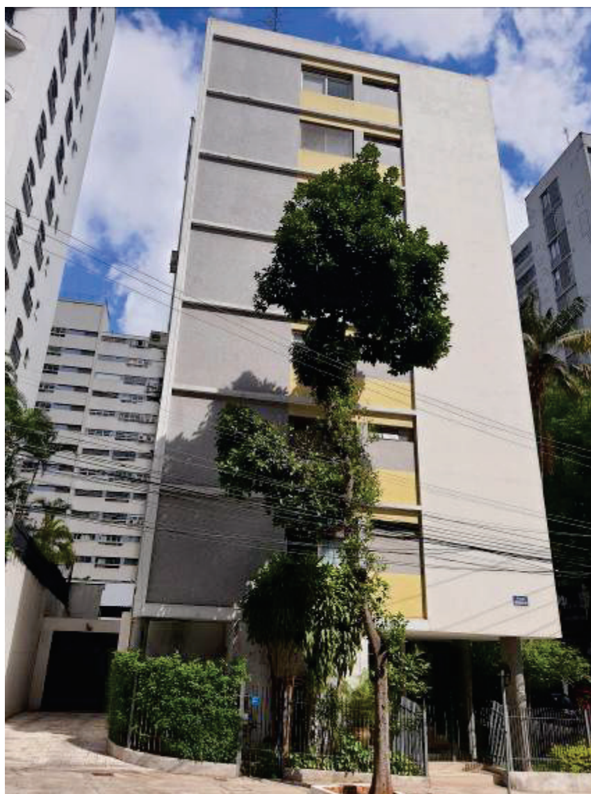
FOTO 5: VISTA GERAL DO EDIFÍCIO ZULMIRA SENDO OBSERVADO PELA RUA ALBUQUERQUE LINS.
