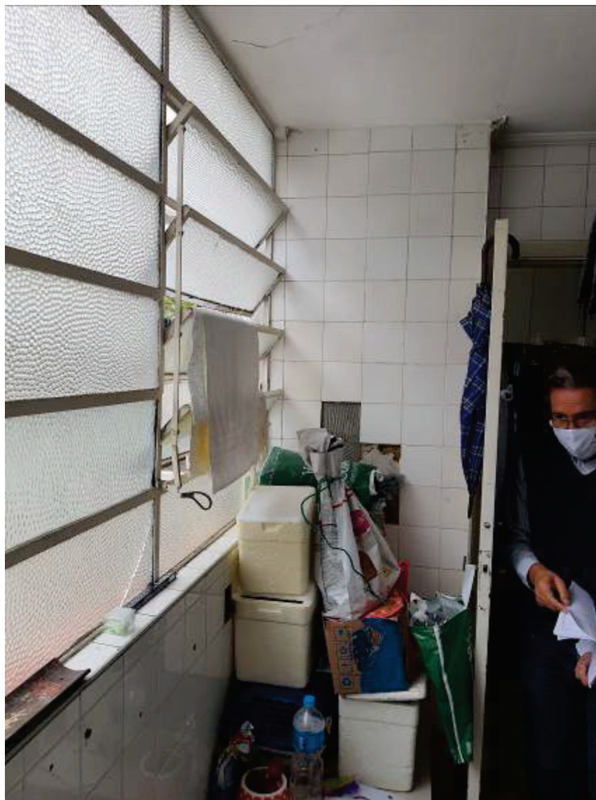
FOTO 28: OUTRA VISTA DA ÁREA DE SERVIÇO.
