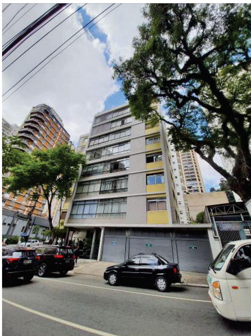
FOTO 6: OUTRA VISTA GERAL DO EDIFÍCIO ZULMIRA SENDO OBSERVADO PELA RUA DR. VEIGA FILHO.
