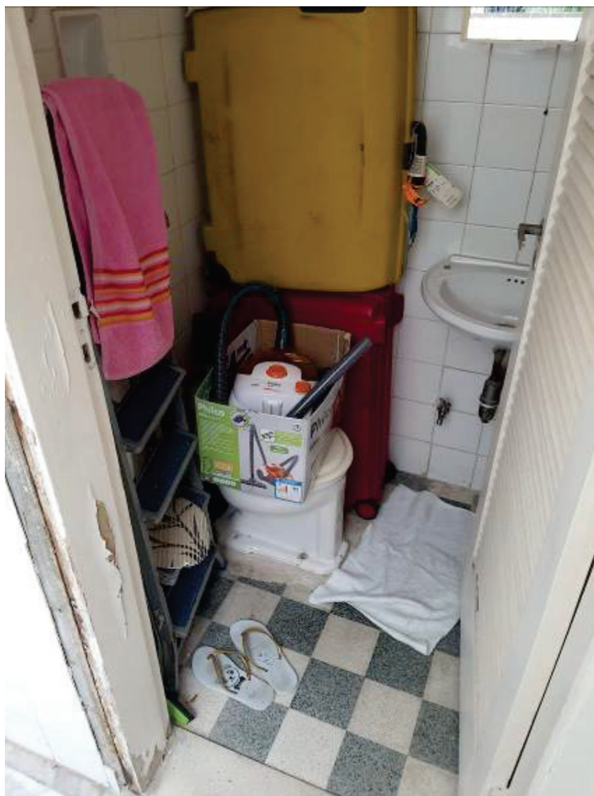
FOTO 30: BANHEIRO DE EMPREGADA.
