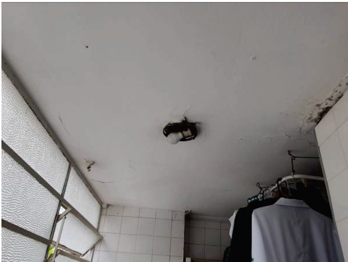
FOTO 29: VISTA DO TETO DA ÁREA DE SERVIÇO.
