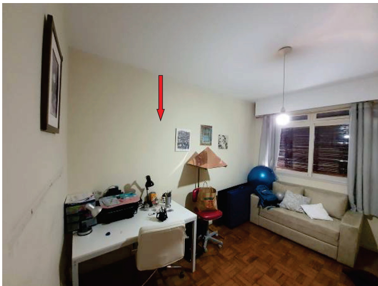
FOTO 15: VISTA DO ESCRITÓRIO, OBSERVANDO A PAREDE DO LADO ESQUERDO EDIFICADA PELA REQUERIDA NA REFORMA.
