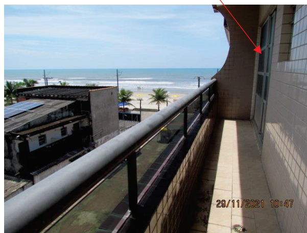
vista para a frente (praia) – porta da lavanderia
