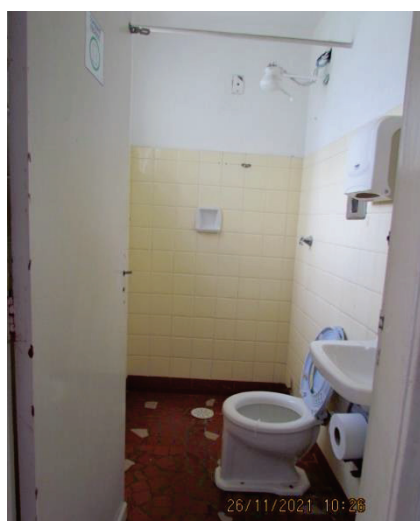
WC na garagem
