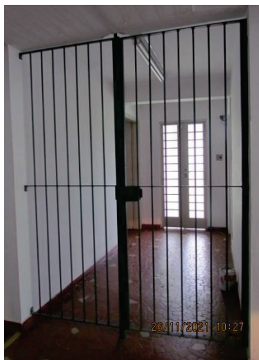
passagem para acesso ao nível da rua
