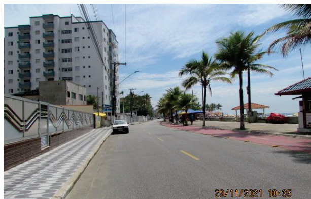
Vista frontal Edifício Beira Mar
