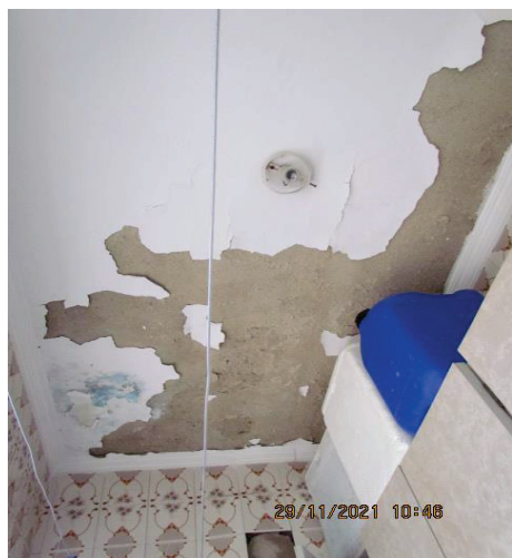
Moldura do teto danificada
