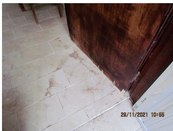
detalhe porta da cozinha (acesso à lavanderia) desgaste junto ao piso (pó da madeira)
