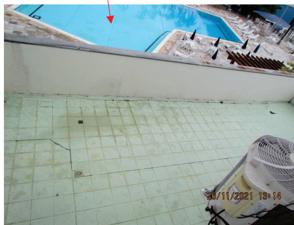
piso do terraço com trincas – ao fundo piscina do Clube Ipanema
