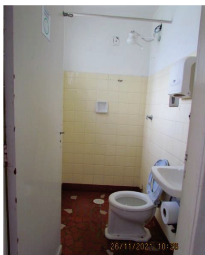
WC na garagem
