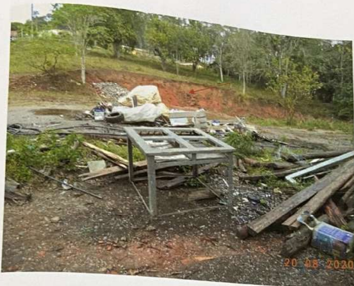
Foto 11 - Dentro do imóvel olhando no sentido da rodovia, nota-se que a terra foi retirada
