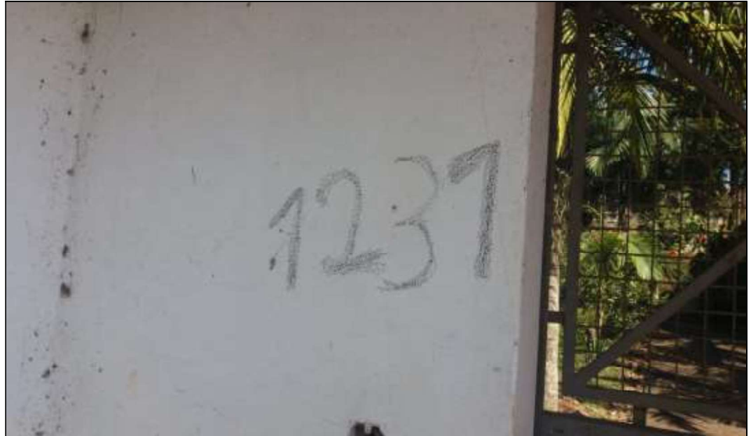
Foto 1 – Vista da fachada do imóvel
