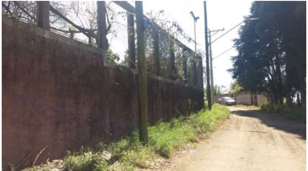
Foto 6 – Vista da Rua Puruba com o imóvel vizinho a esquerda
