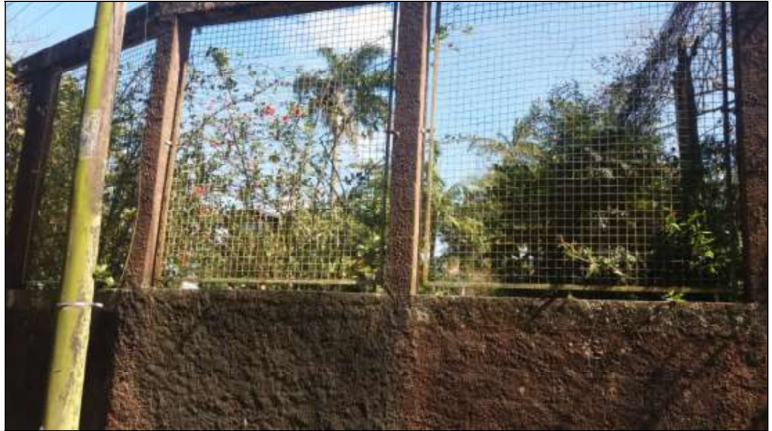
Foto 3 – Vista da fachada do imóvel
