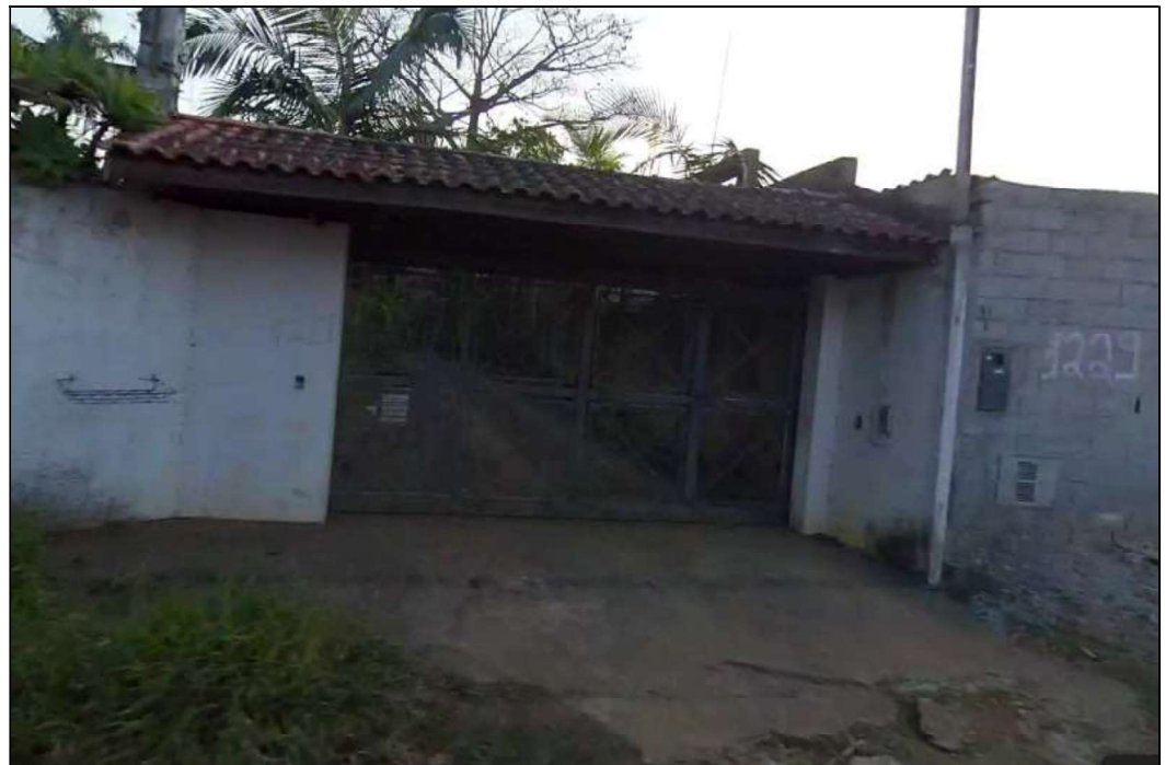
Foto 2 – Vista da fachada do imóvel
