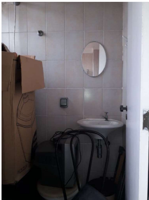
Vista Banheiro secundário
