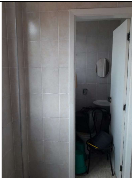
Corredor de Acesso banheiro secundário
