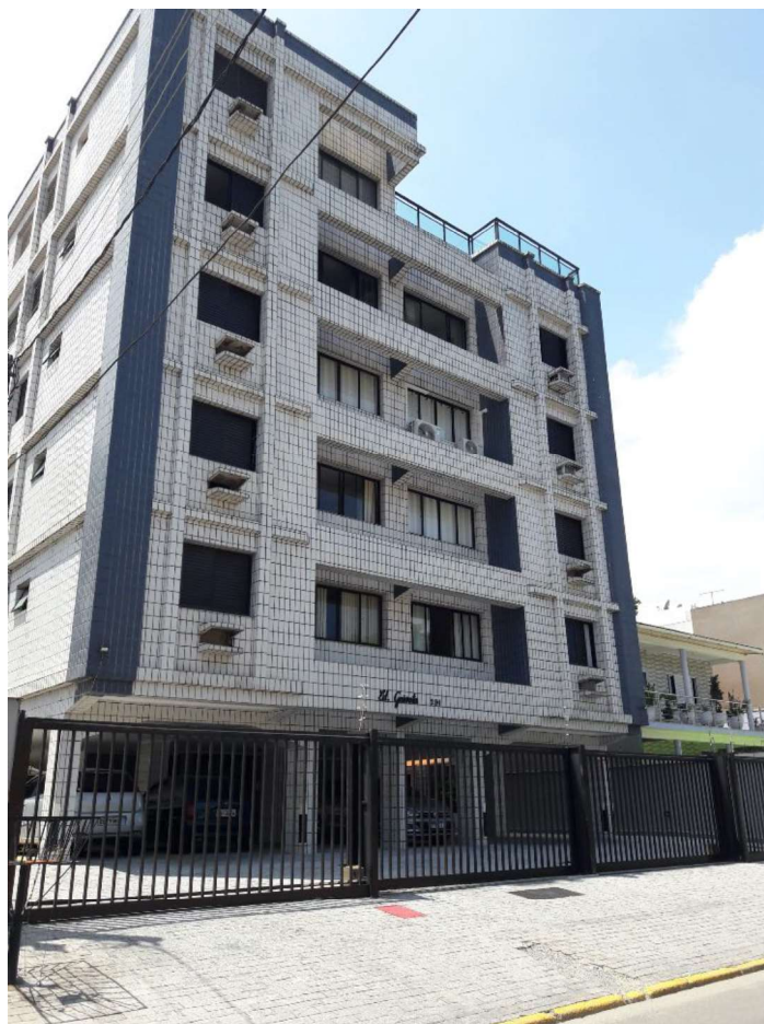
Foto 01 - Fachada – "CONDOMÍNIO EDÍFICIO GAIVOTAS VI"
