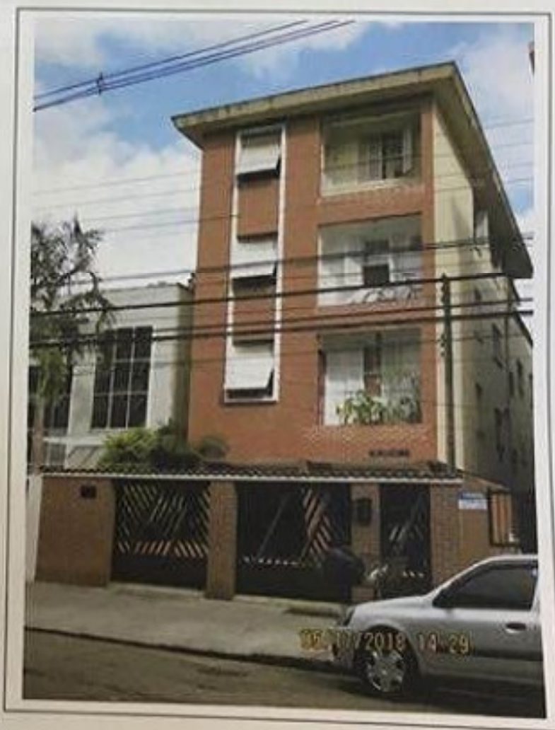
Foto 01 - Fachada frontal do Cond. Edifício Vicente Paulo.
