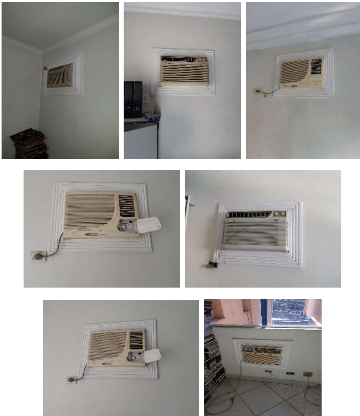
Detalhes Gerais - Ar – Condicionado tipo janela
