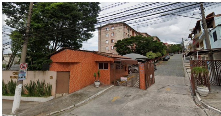
Vista portaria Condomínio Residencial Sul
