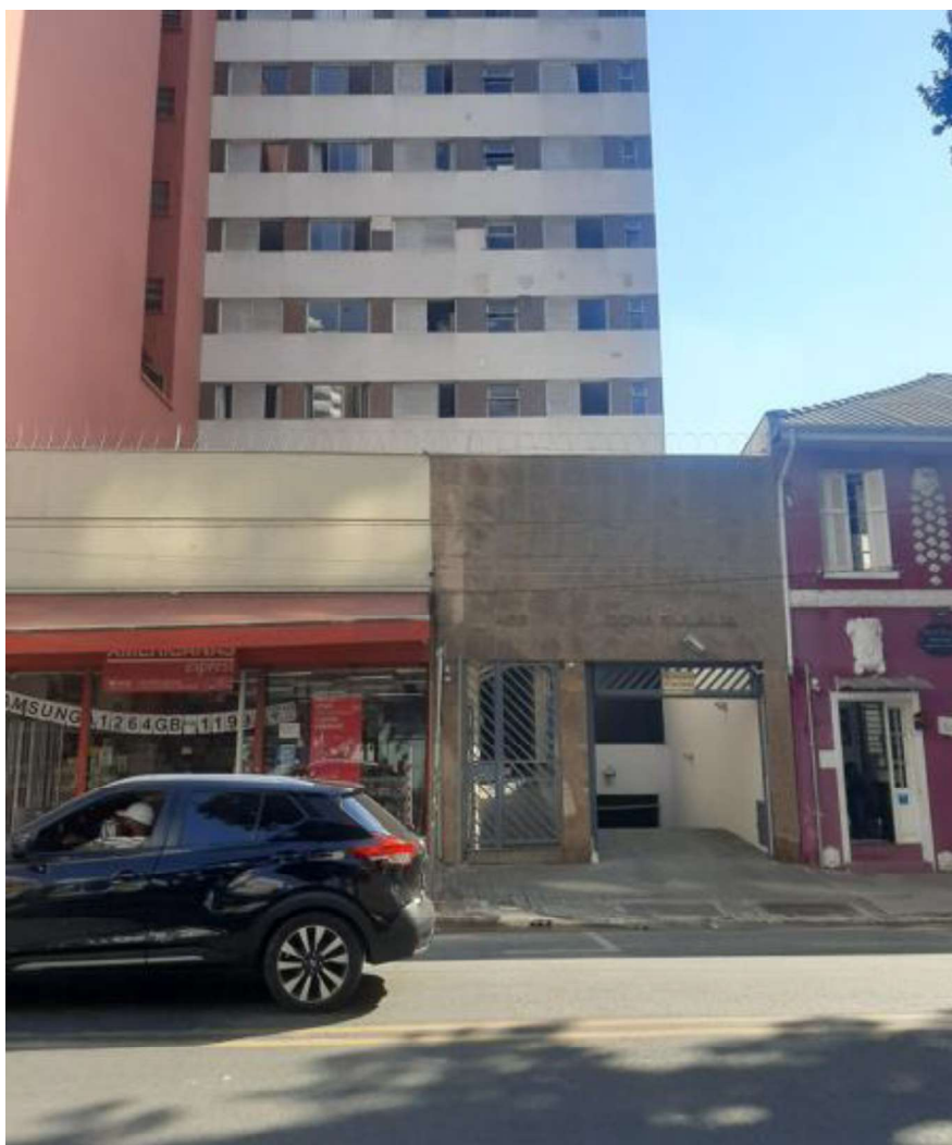
FOTO 01 Vista parcial Fachada Edifício Dona Eulália
