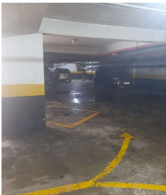
FOTO Nº 10 Vista parcial Garagem
