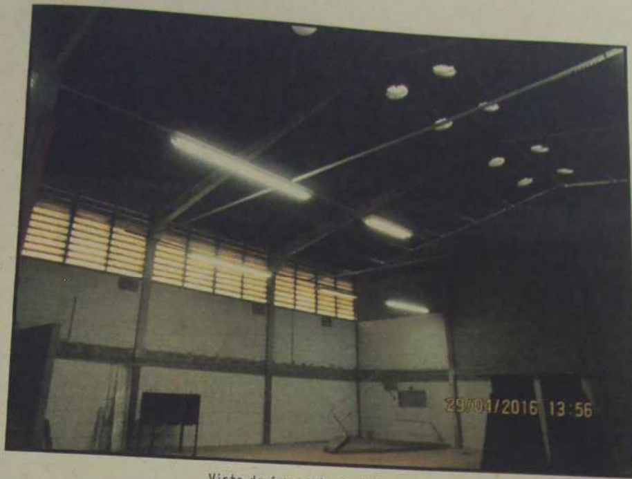
Vista da área principal do galpão
