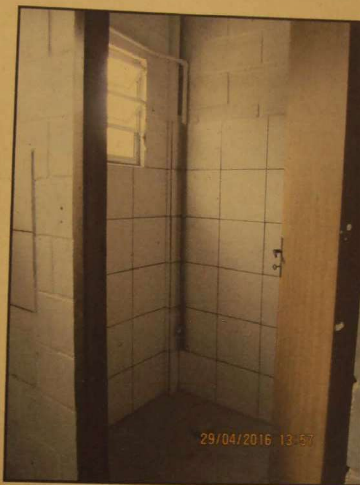
Vista interna do lavabo - área administrativa
