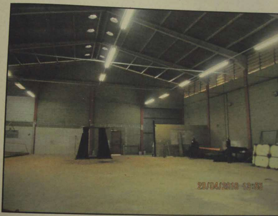
Vista da área principal do galpão
