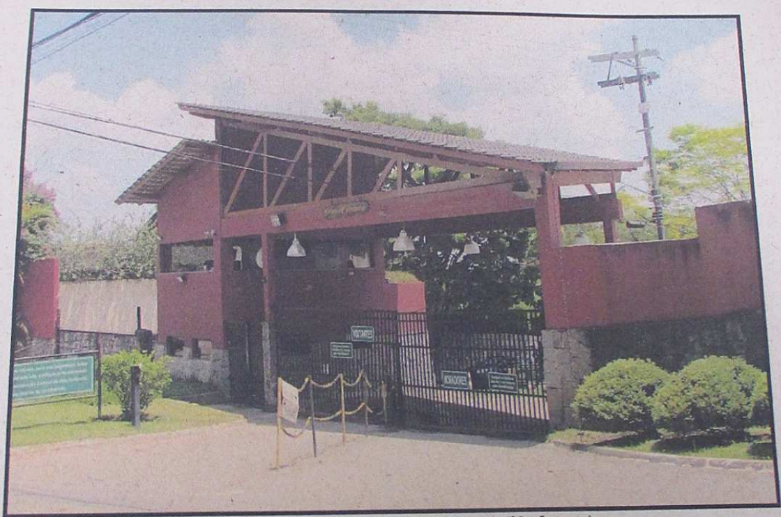
Vista da portaria do condomínio Colinas do São Fernando.
