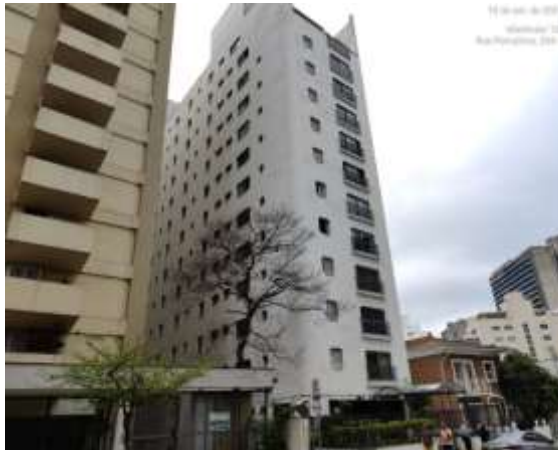
Figura 9 – Fachada lateral esquerda
