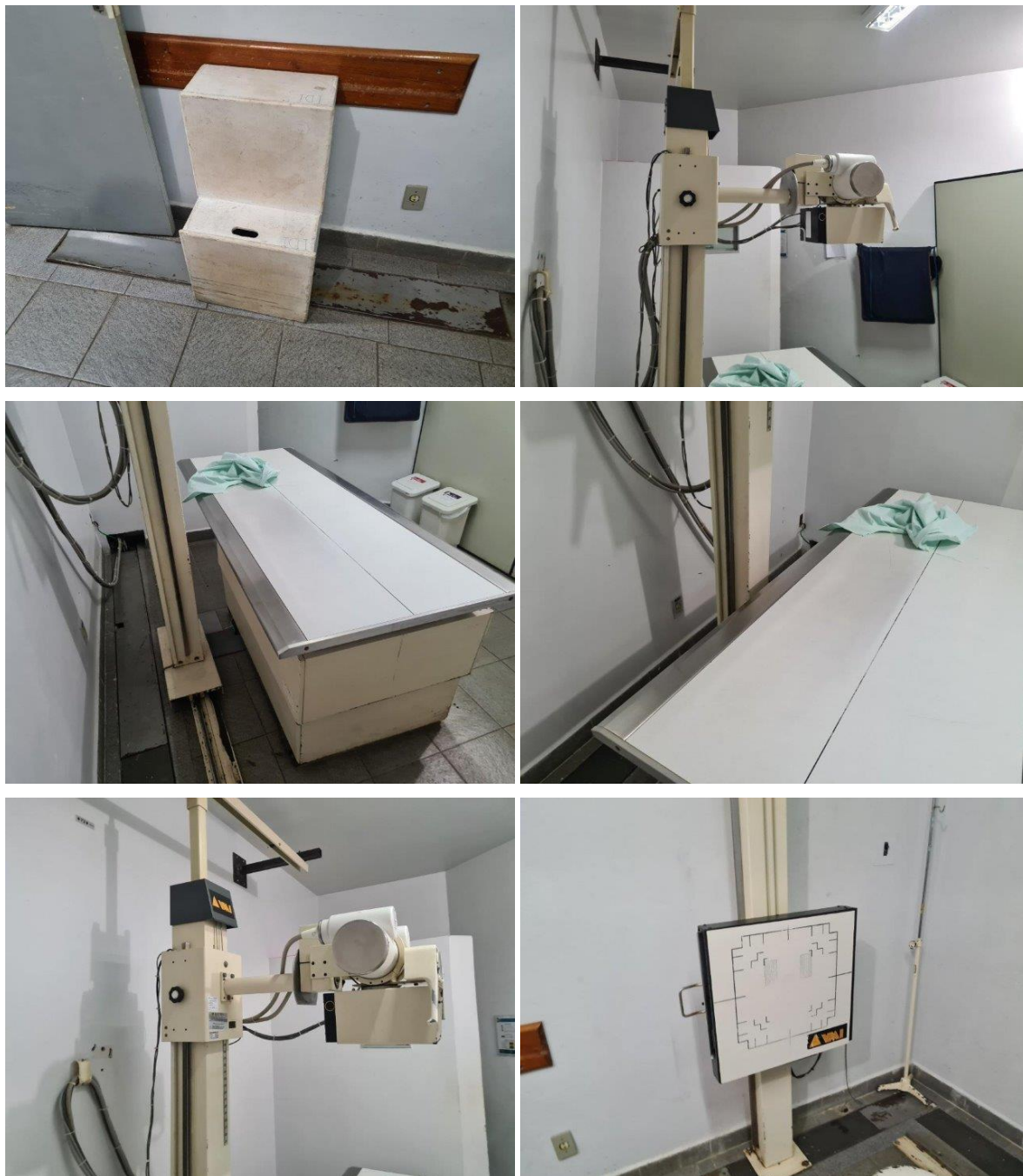
Detalhes Sala de Raio-X 1 Equipamentos de Raio-X
