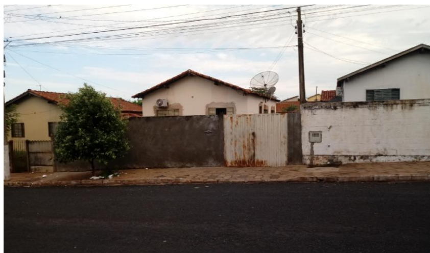
Casa residencial situada à Rua Vicente Esteves Aguilar, nº.56, Jardim São Francisco;
