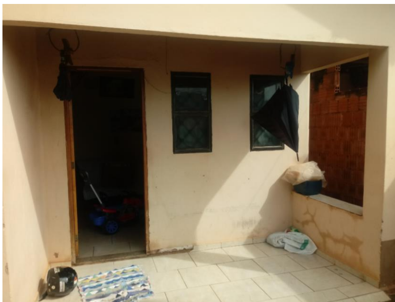
VARANDA DO IMÓVEL AVALIANDO
