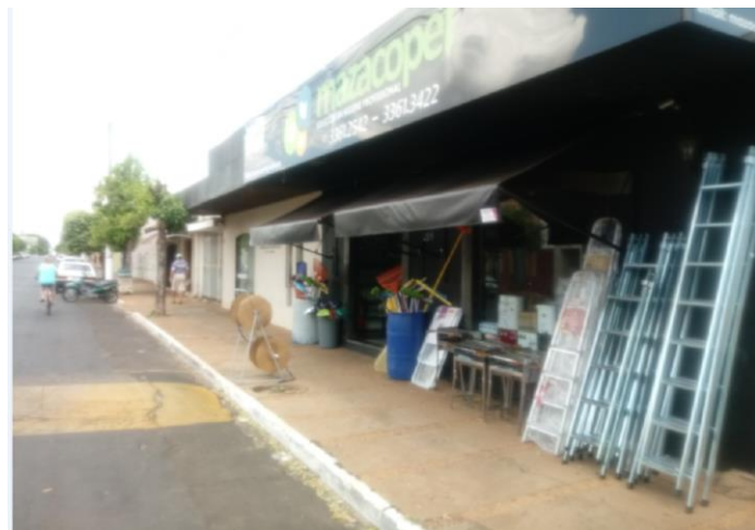
Casa residencial / comercial, situada à Rua São Pedro, nº.451 / 459, centro;
