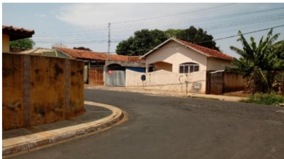
Casa residencial situada à Rua Ricardo Lopes de Queiróz, nº.90, centro;
