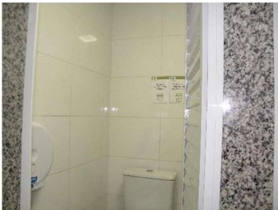
VISTA DO REVESTIMENTO INTERNO DO BANHEIRO.
