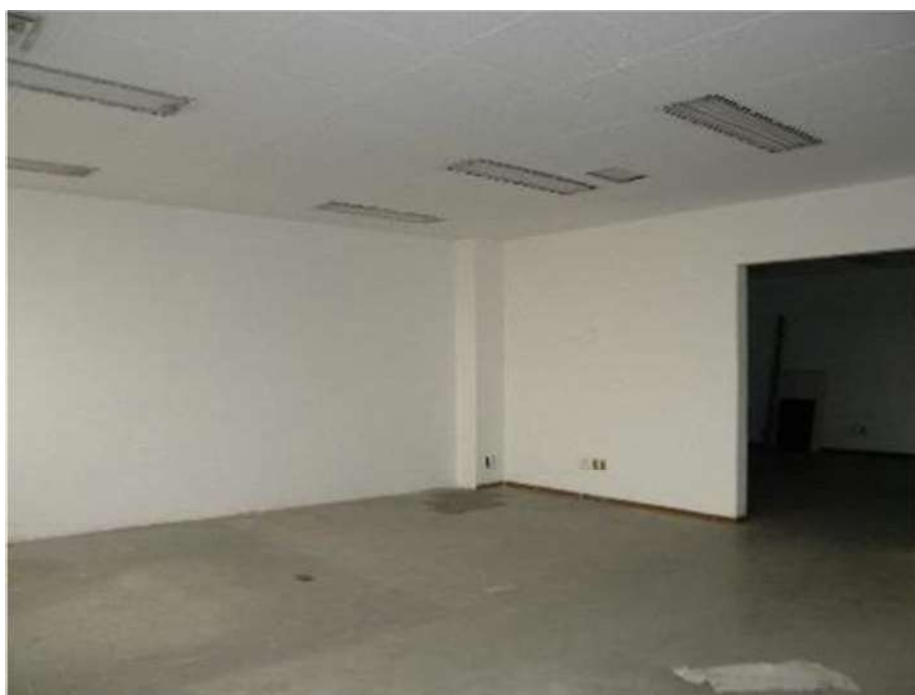
VISTA DO PISO E DO FORRO DA SALA 717.
