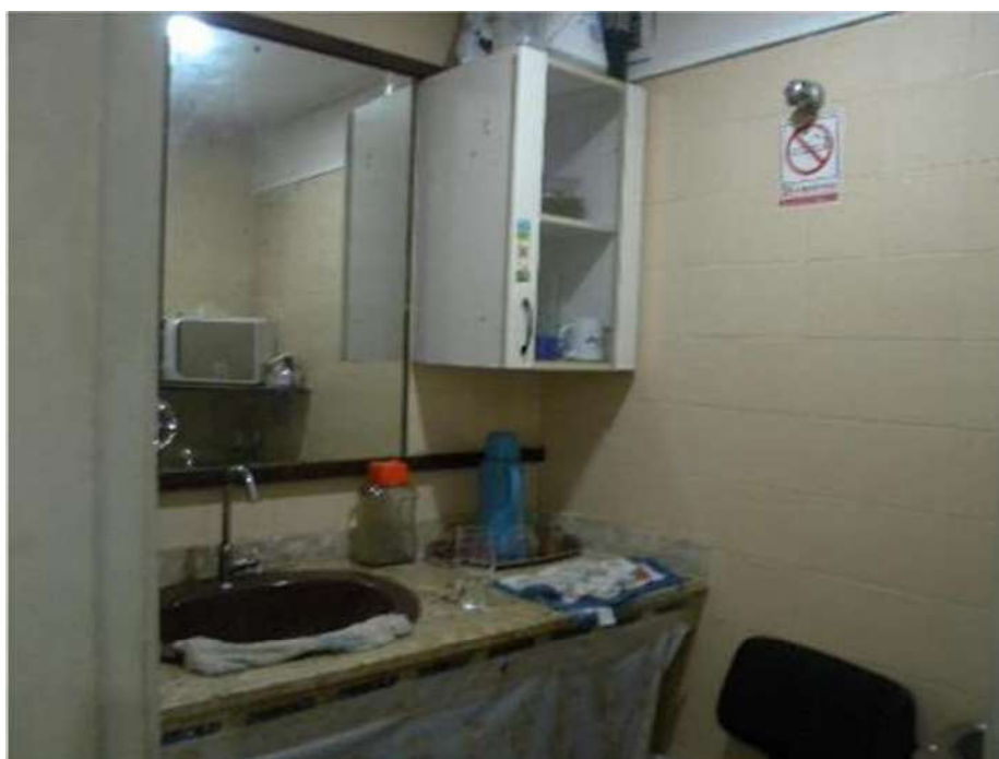
VISTA DO BANHEIRO DA SALA 731.
