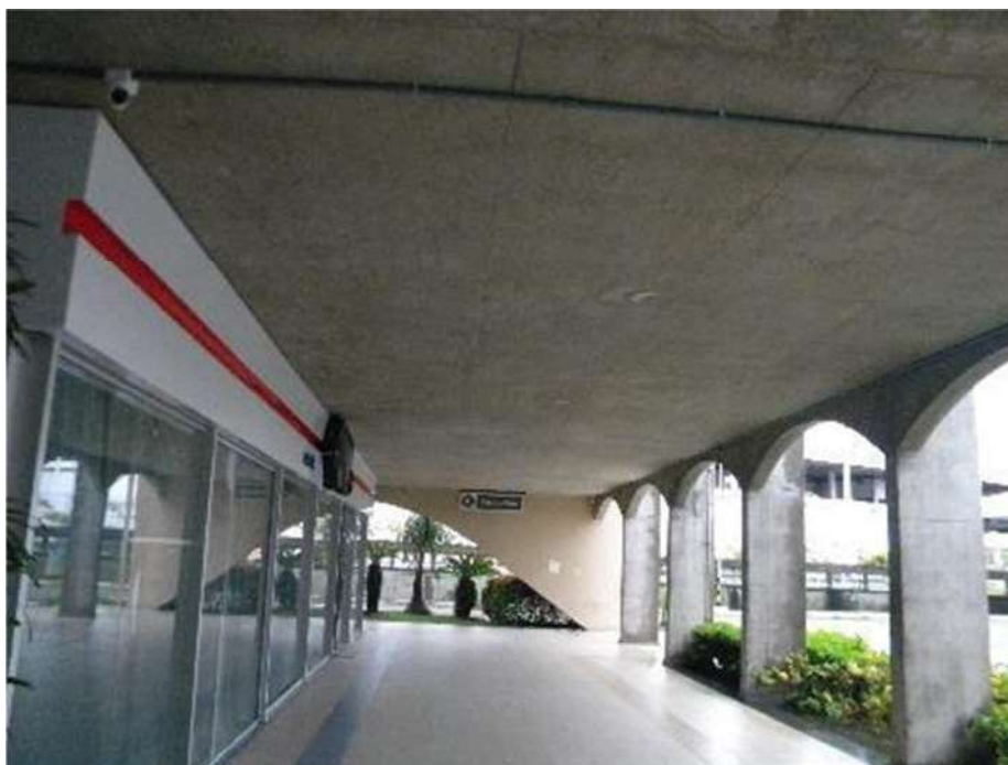
VISTA DO VÃO DE ACESSO AO HALL DE ENTRADA.
