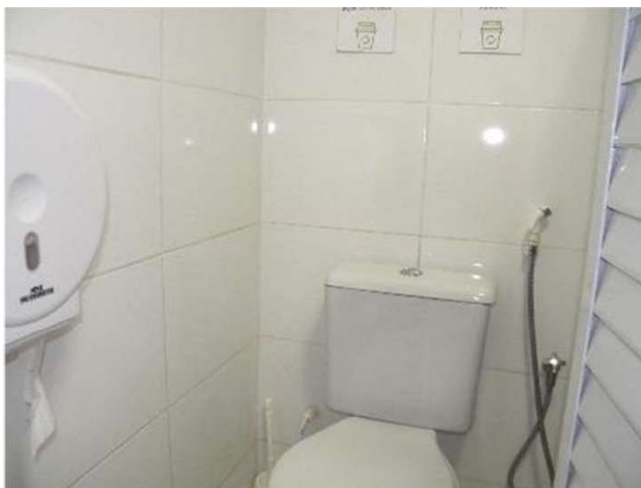
VISTA DO REVESTIMENTO INTERNO DO BANHEIRO.
