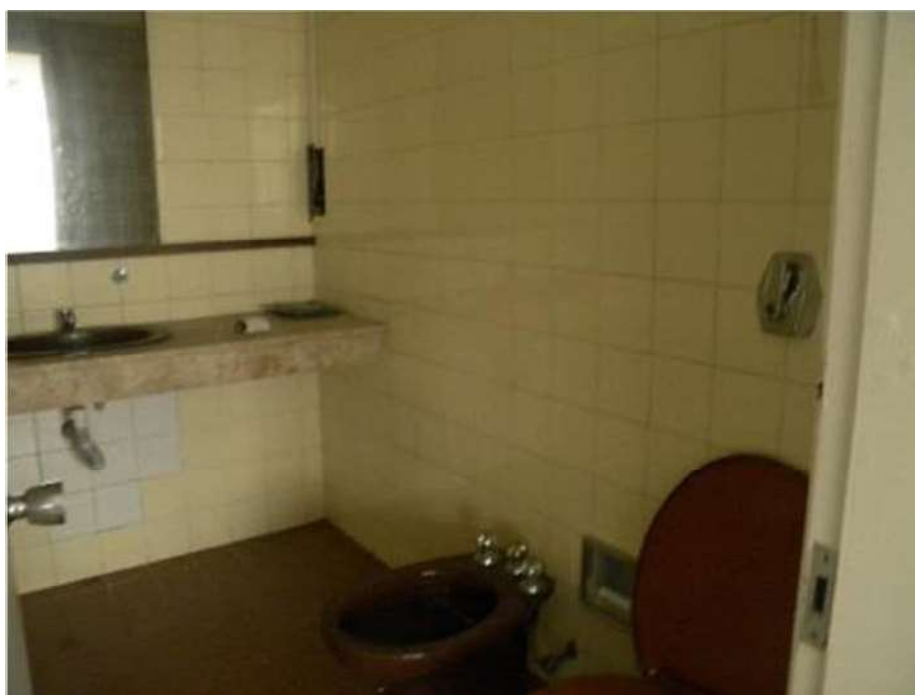
VISTA DO BANHEIRO DA SALA 717.
