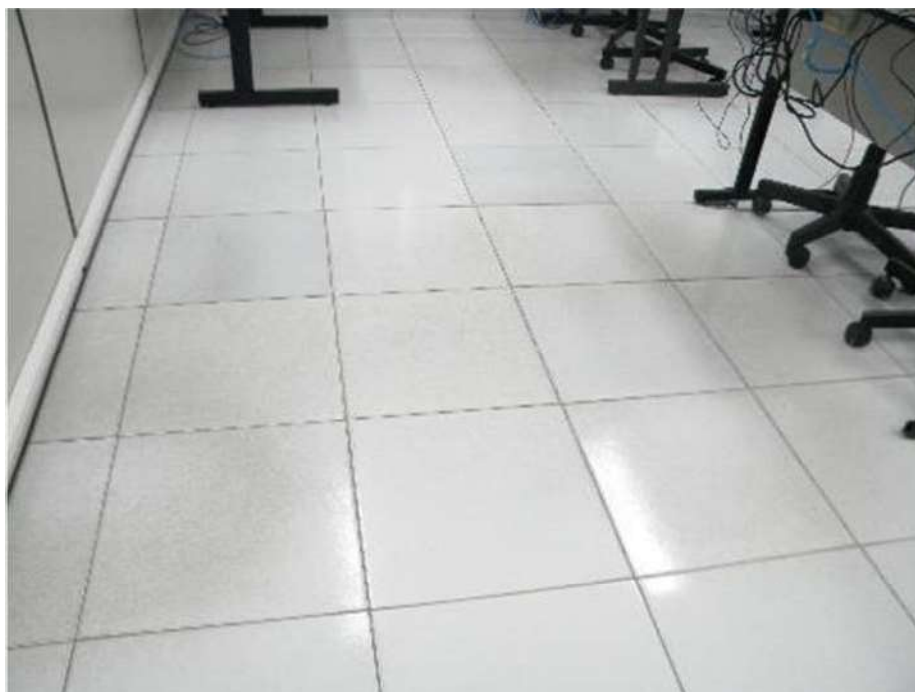
VISTA DO PISO DO CONJUNTO DE SALAS.
