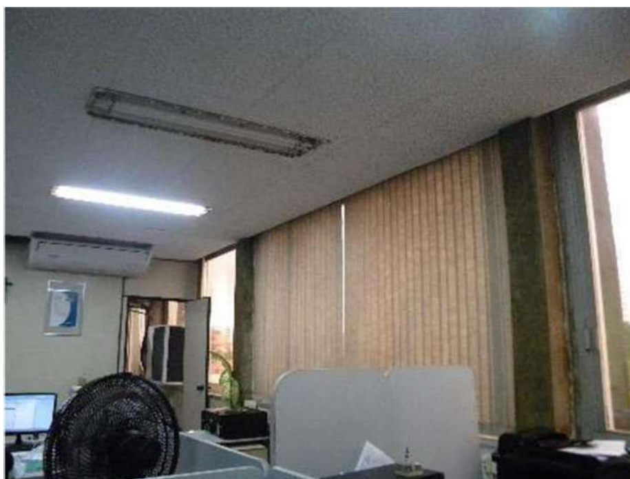
VISTA DO FORRO COM ILUMINAÇÃO, AR CONDICIONADO E JANELAS DAS SALAS 727 E 728.
