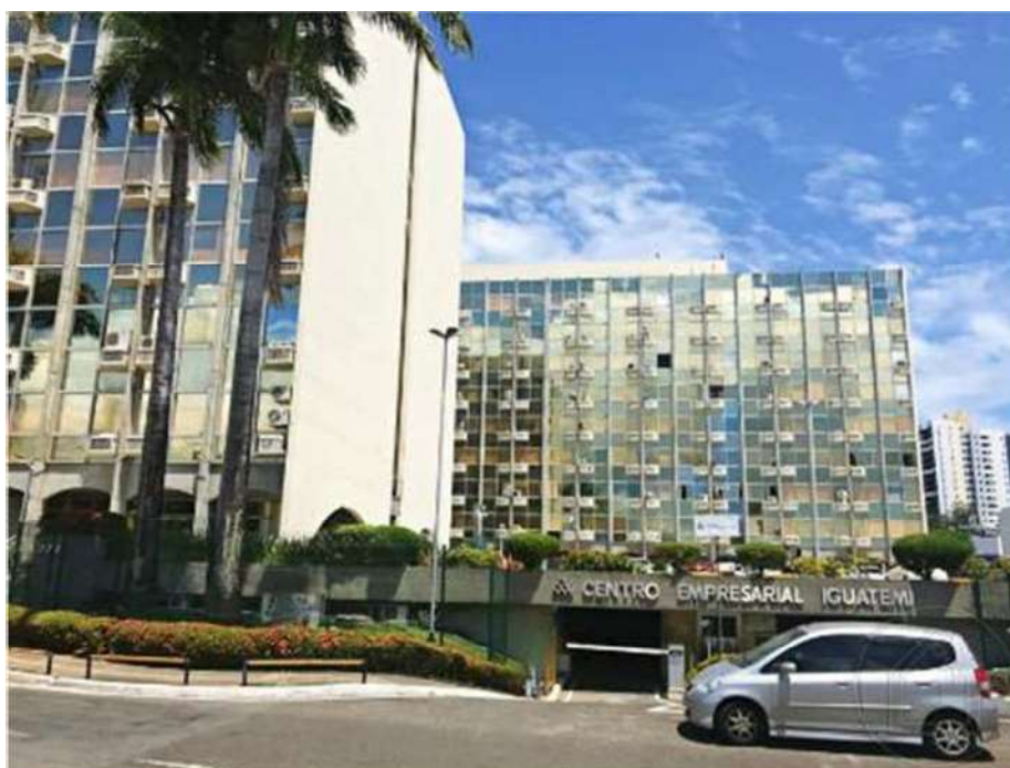
VISTA DO ACESSO AO ESTACIONAMENTO DO SUBSOLO.
