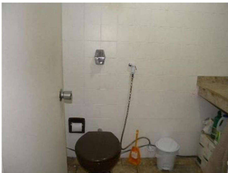
OUTRA VISTA DO BANHEIRO DA SALA 730.
