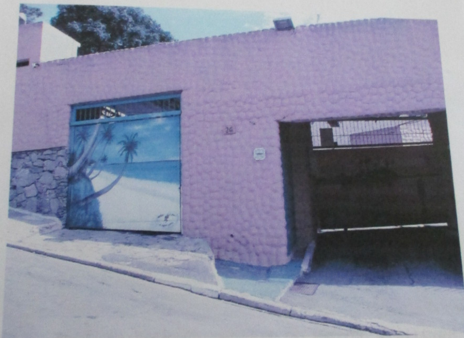
FOTO 1 - VISTA DEFRENTE AO IMÓVEL AVALIANDO
