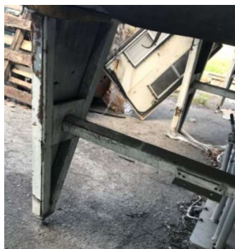
(Fig 09 – Estrutura da Estufa)
