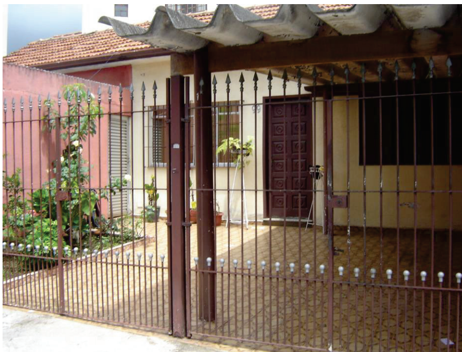
Vista frontal da casa construída de frente para a rua Rio Verde
