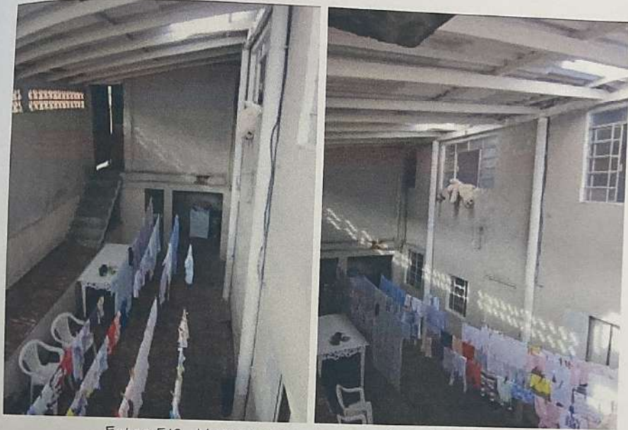
Fotos 5/6 - Vistas parciais do recuo frontal do imóvel.
