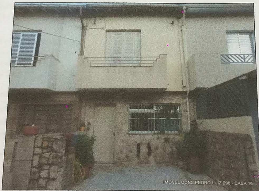
07- Fachada do Imóvel Objeto
