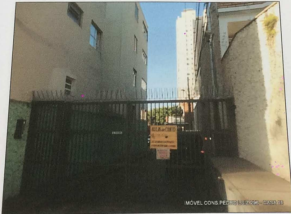
03- Entrada Portão de segurança
