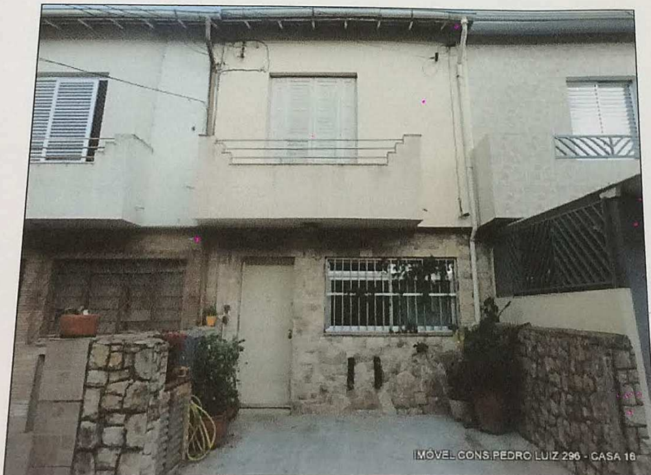
07- Fachada do Imóvel Objeto
