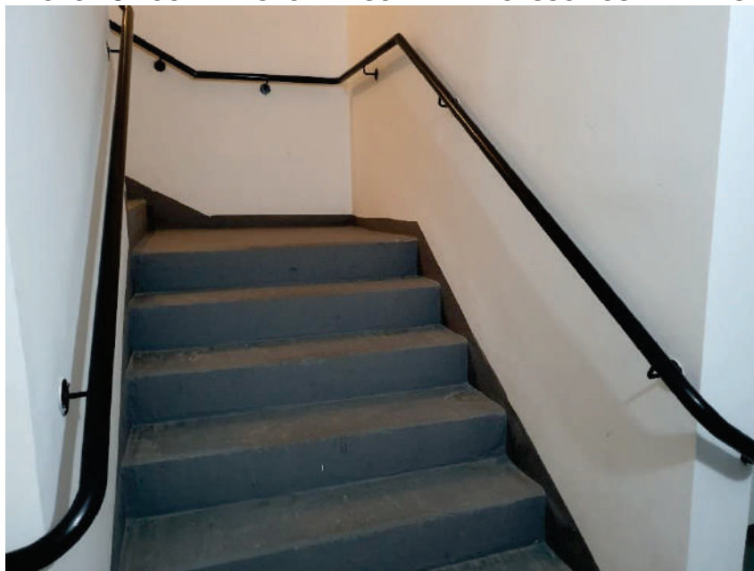
FOTO 15 –OUTRA VISÃO DA ESCADA DE ACESSO AOS ANDARES
