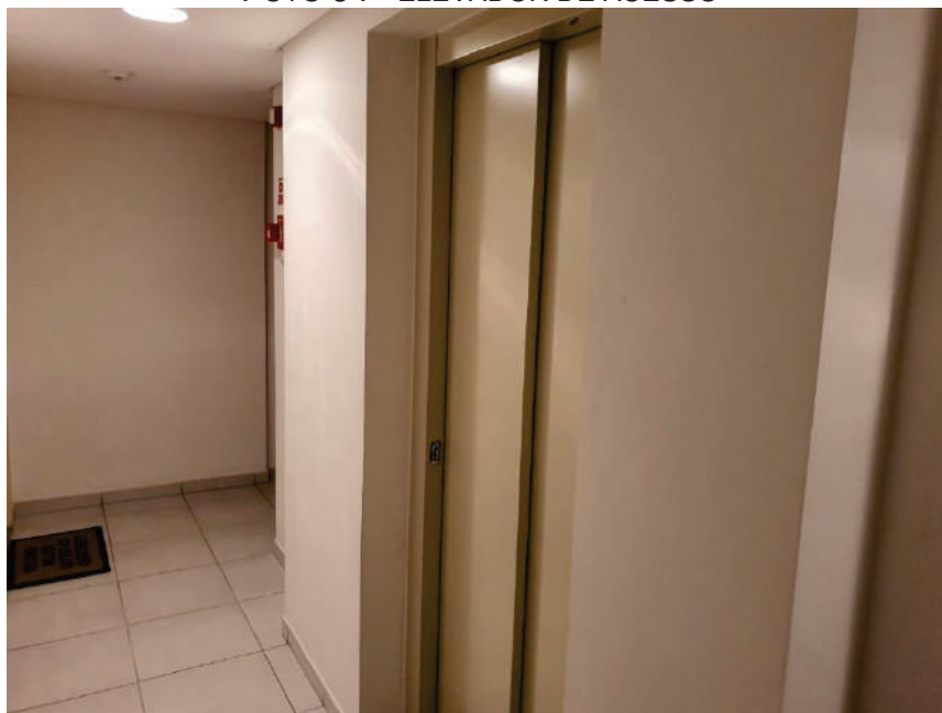
FOTO 64 –ELEVADOR DE ACESSO
