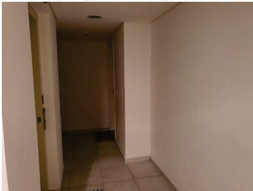
FOTO 42 – CORREDOR DE ACESSO A UNIDADE
