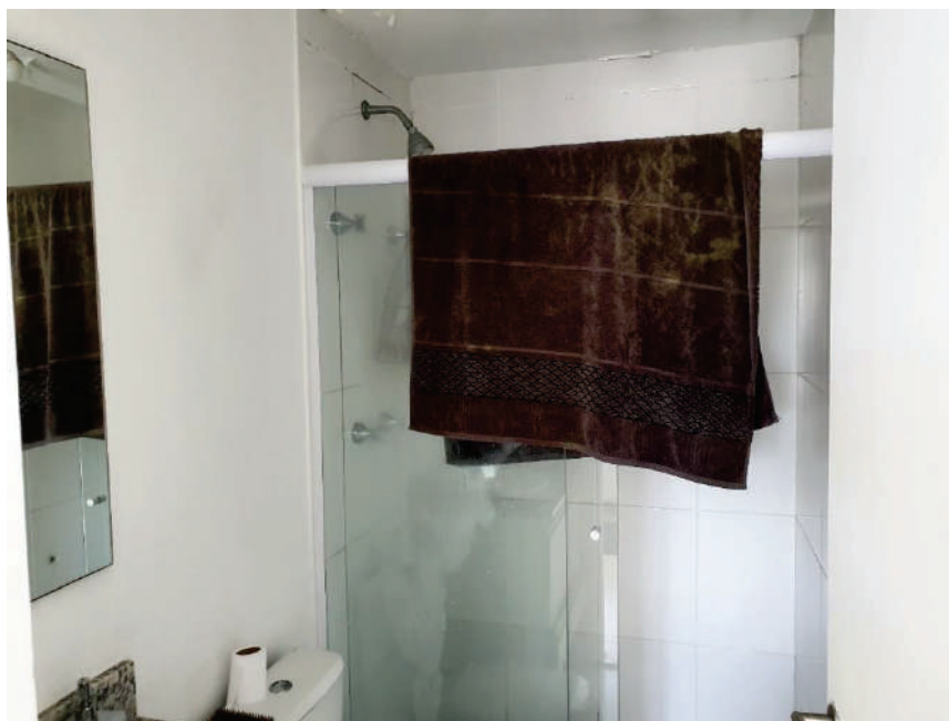
FOTO 50 –BANHEIRO DA SUÍTE
