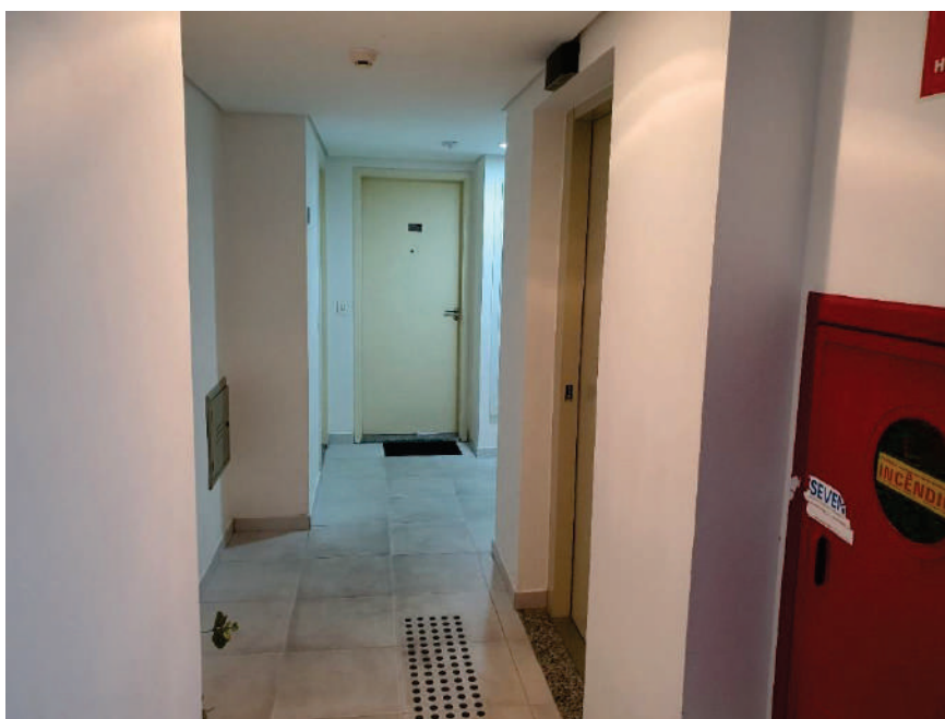
FOTO 24 –OUTRO ÂNGULO DO CORREDOR DE ACESSO A UNIDADE
