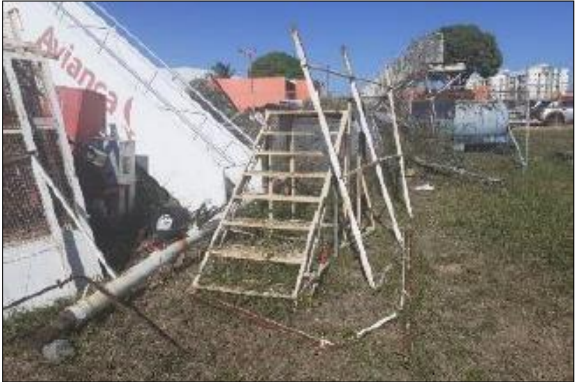
ITEM 7,004 – ESCADA PLATAFORMA
