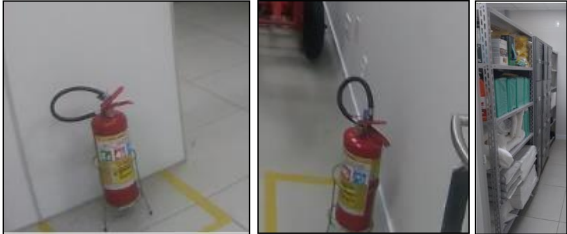
ITEM 3,063 – EXTINTORES E ITEM 3,065 -ARMÁRIO DE VESTIÁRIO
