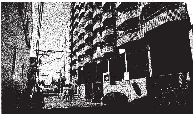
Foto 4 – Vista da fachada do Condomínio Residencial Erick Lucas e Wesley.
