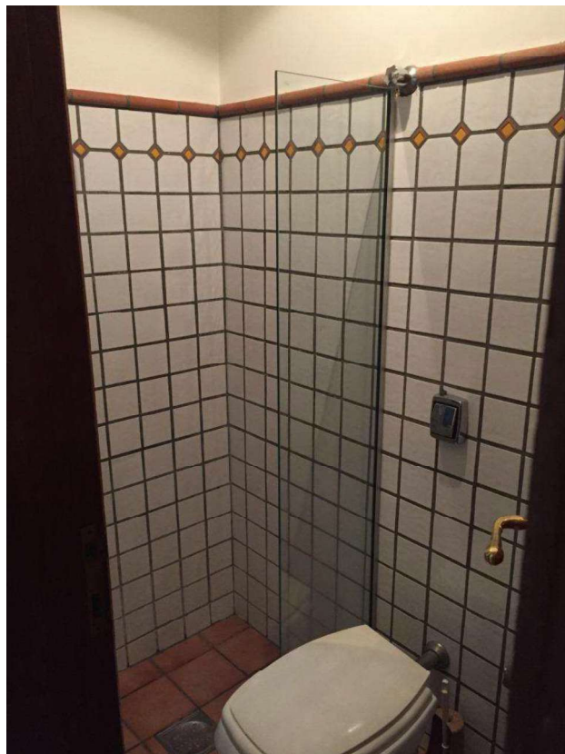
Foto 04 – Banheiro de empregada
