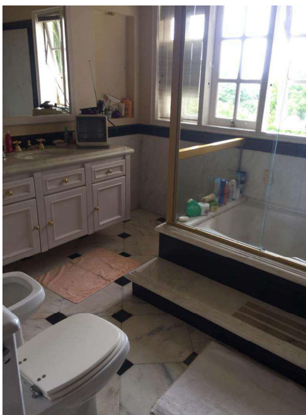
Foto 26 – Banheiro da suíte 03
