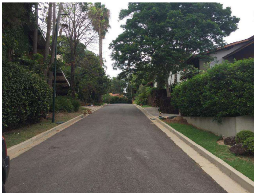
Foto 29 – Rua interna do condomínio
