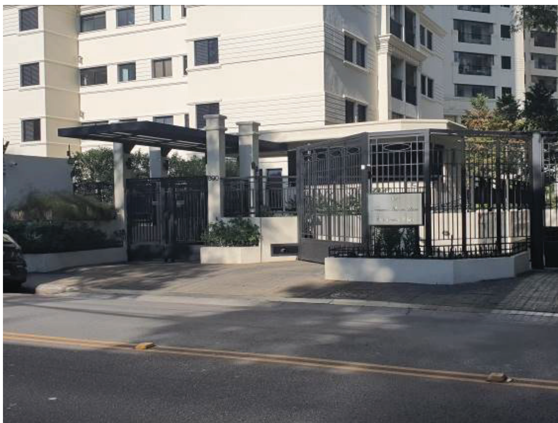
FOTO 9: PORTARIA DO CONDOMÍNIO.
