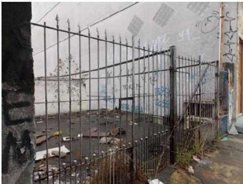
Foto nº 1 – Gradil frontal do imóvel.
