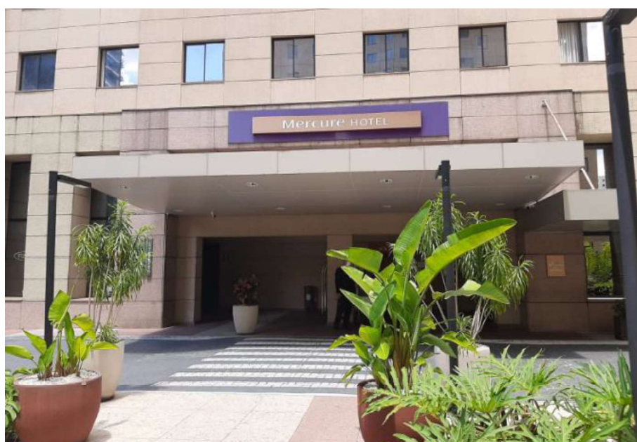
FOTO Nº 02 Vista Parcial da Fachada do Bloco A Diamond Flat
