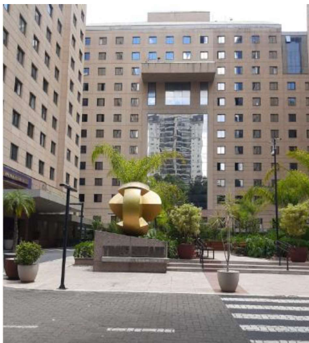
FOTO Nº 01 Vista Parcial da Fachada do Condomínio Edifício Times Square
