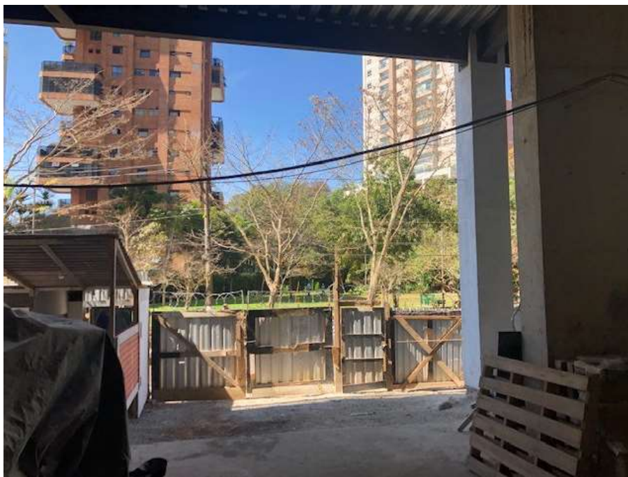
PORTARIA DE ENTRADA ATUAL
