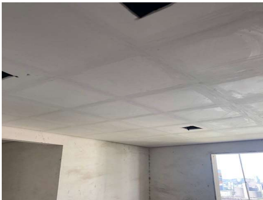
ASPECTOS DO APARTAMENTO- FORRO DE GESSO
