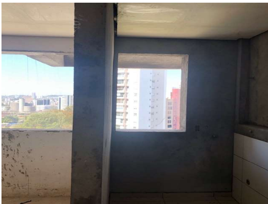
ASPECTOS DO APARTAMENTO- FORRO DE GESSO
