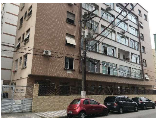
Fachada do Condomínio – vista da Rua Candido Rodrigues.
