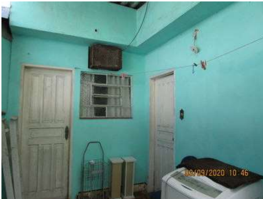
Fotos 09 e 10 – Fachada da Edícula.
