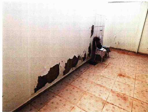
FOTO 52 – VISTA INTERNA FUNDOS PAREDE COM DEFEITO NA PINTURA
