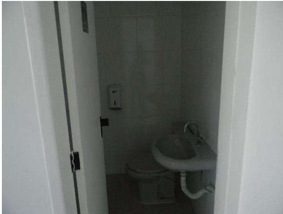
Foto nº 11 – Vista do WC do conjunto avaliando.
