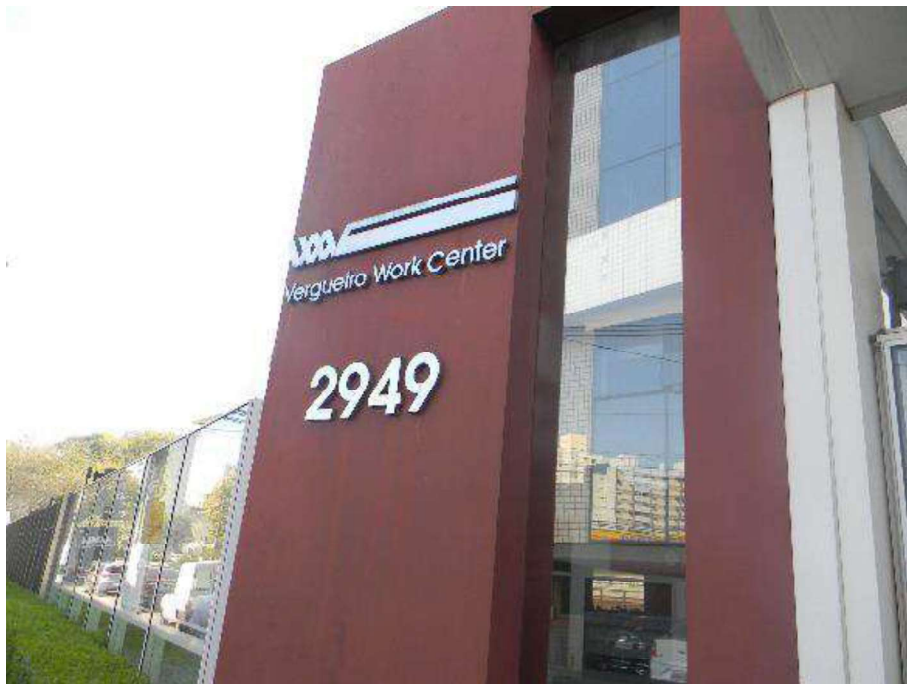
Foto nº 05- Entrada do edifício.
