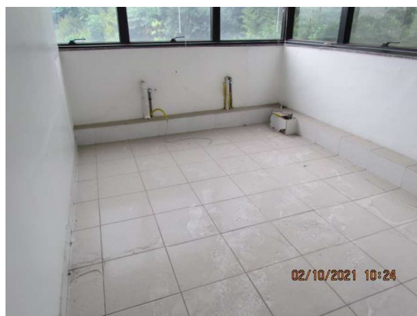
rodapé com caixa para passagem de instalações
