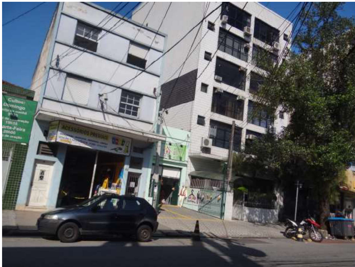
Vista da fachada do edifício.
