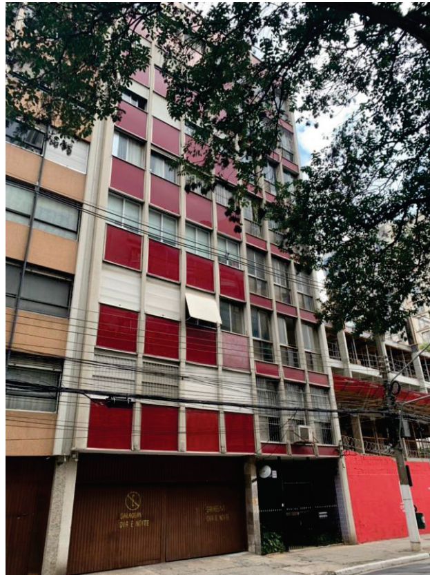
Foto 01 – Frente do imóvel avaliando, Rua dos Bandeirantes, nº 199
