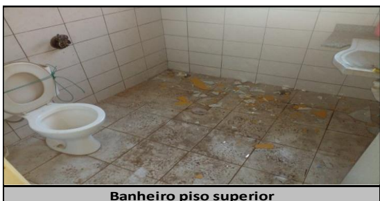
Banheiro piso superior
