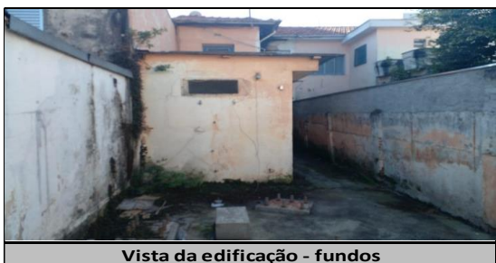
Vista da edificação - fundos
