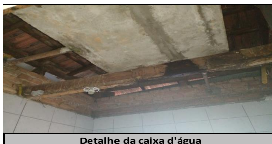
Detalhe da caixa d'água
