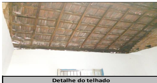
Detalhe do telhado
