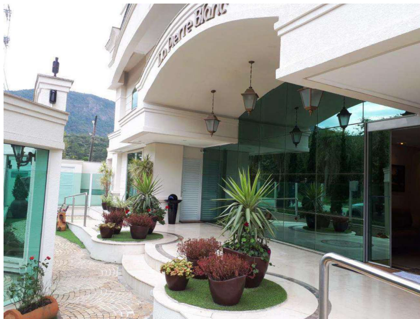
Foto 06 – Entrada do prédio
