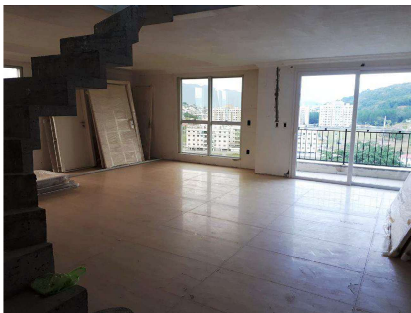
Foto 84 – Sala piso inferior
