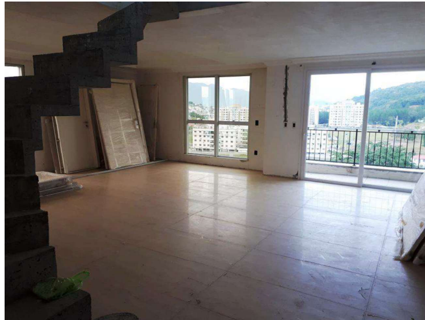
Foto 84 – Sala piso inferior
