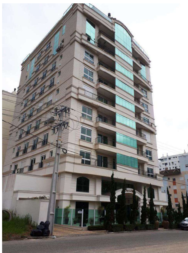
Foto 02 – Condomínio Residencial La Pierre Blanc
