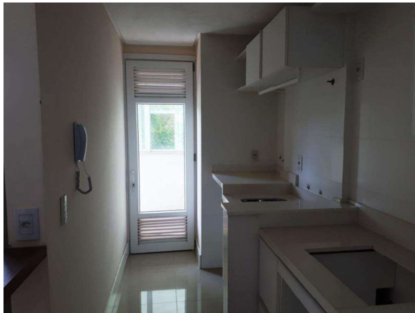
Foto 22 – Área de serviço
