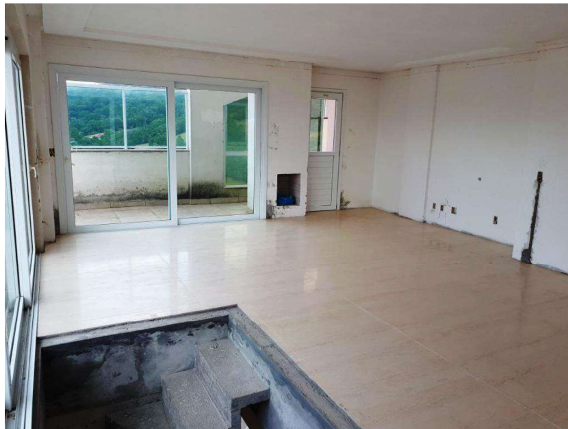
Foto 90 – Sala piso superior
