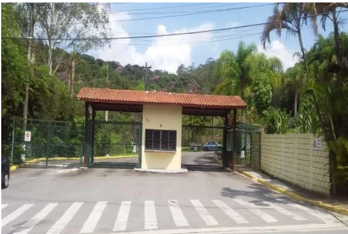
FOTO nº 02 - Vista da portaria de acesso ao Condomínio Morada Verde, onde se localiza o sobrado de nº 13, no Bloco 5.
