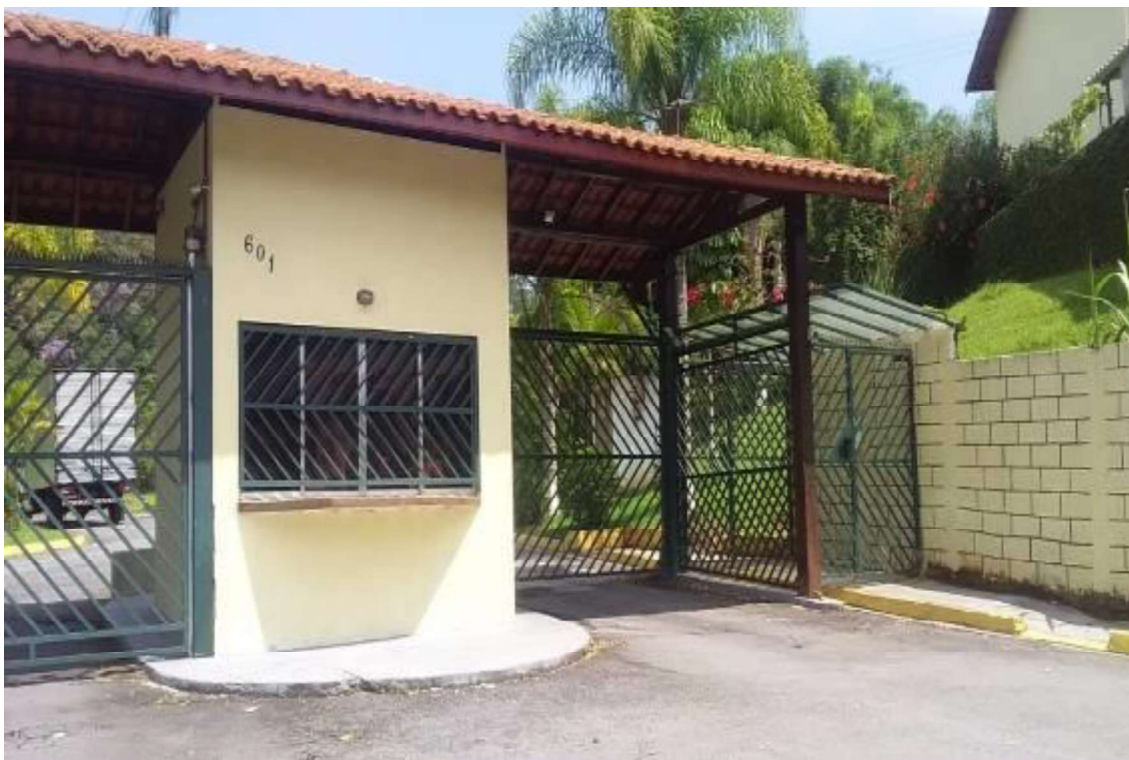
FOTO nº 03 – Outra vista da portaria de acesso do Condomínio Morada Verde.
